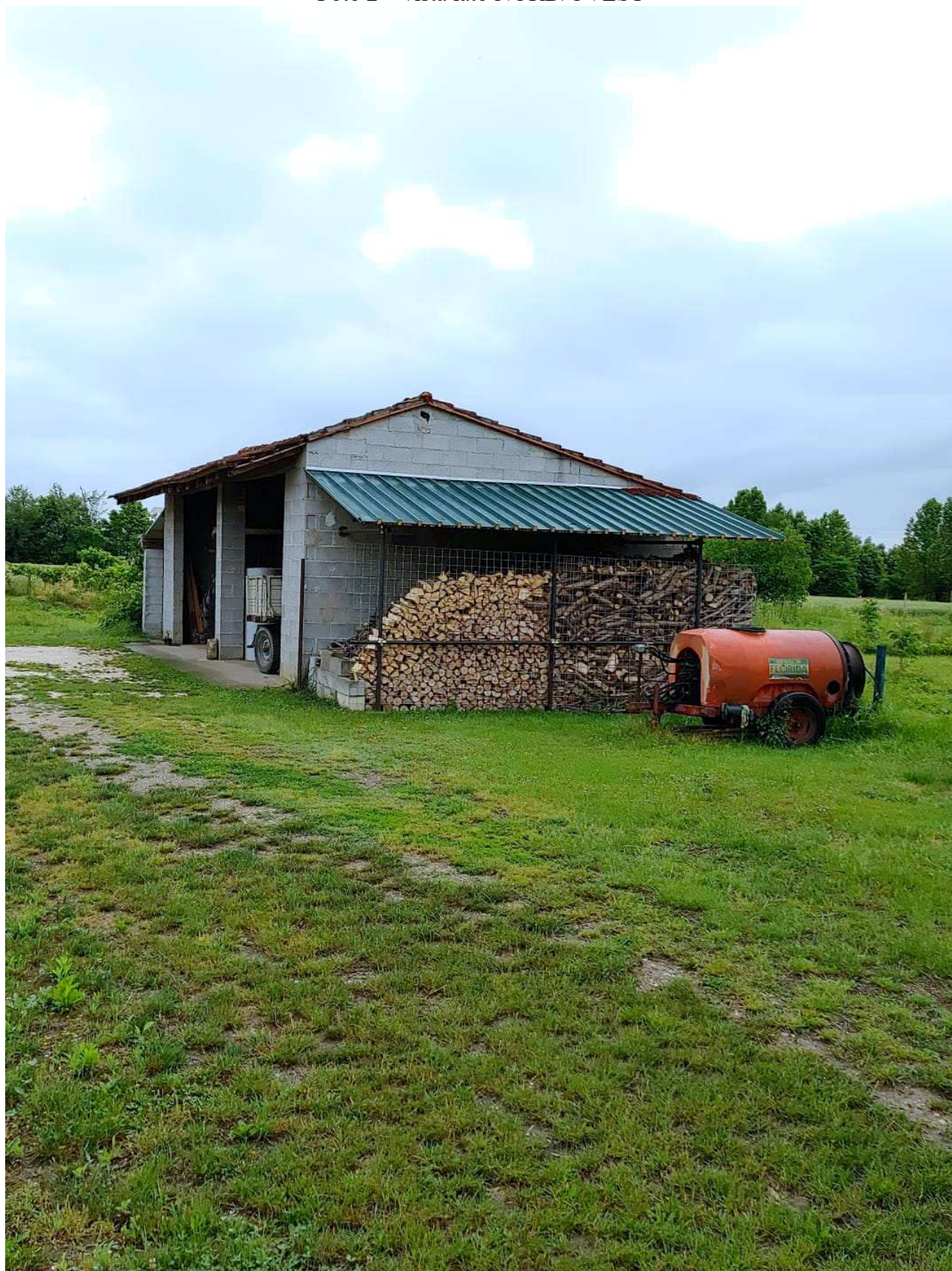
Foto 2 – vista lato NORD/OVEST
