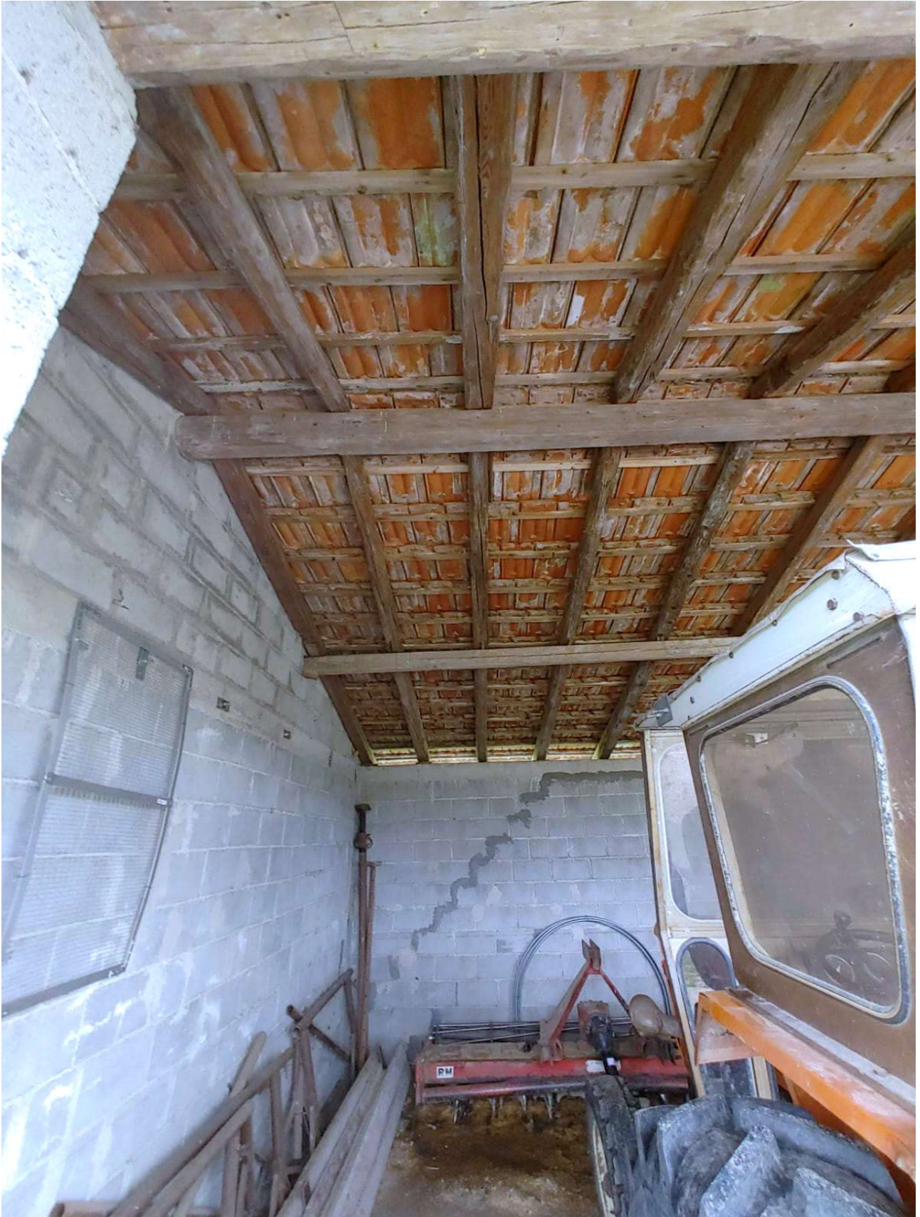
Foto 3 – vista struttura tetto
