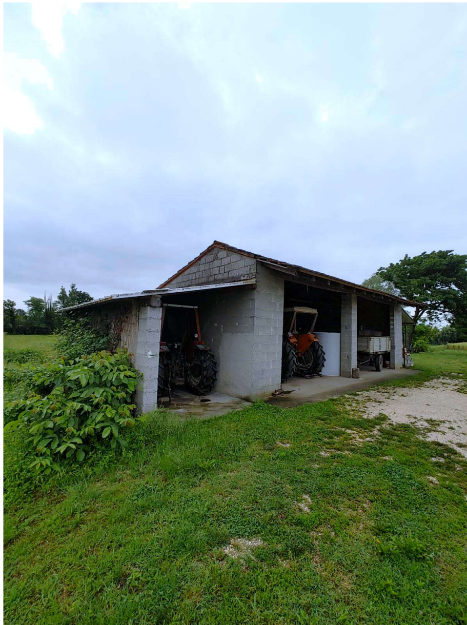
Foto 1 – vista lato NORD/EST
