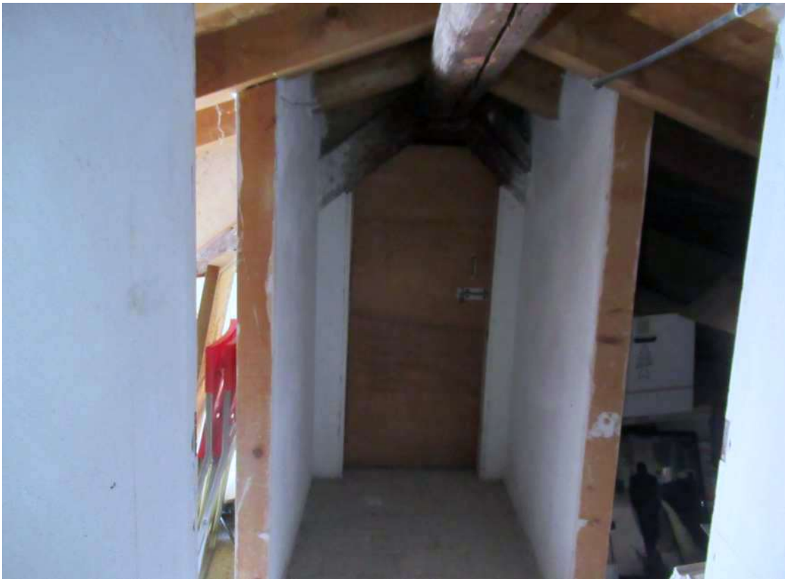
Foto 19: Porta d'accesso al sub 34
