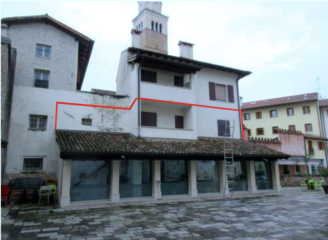
Foto 2: Prospetto Sud appartamento
