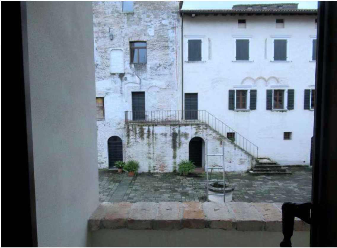
Foto 13: Vista dal terrazzo
