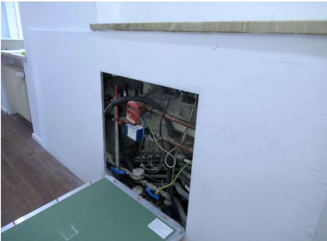
Foto 9: Collettore nel disimpegno
