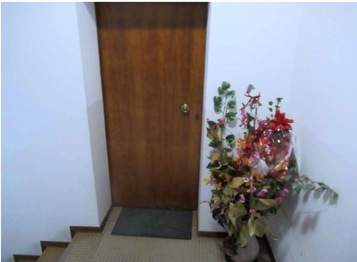
Foto 16: Porta d'accesso alle soffitte
