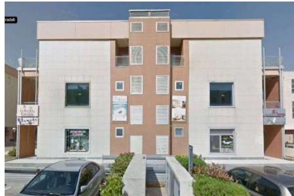
Prospetto laterale sinistro
