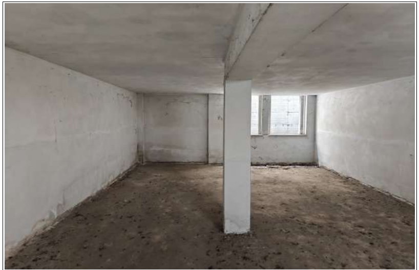
Il locale sgombero, sullo sfondo i vani finestra privi di serramenti
