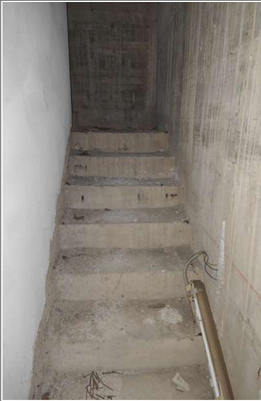
La scala di comunicazione tra box auto e locale sgombero
