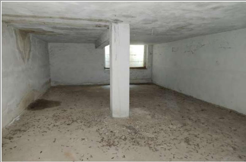
Il locale sgobero
