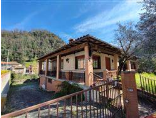
vista abitazione dalla via Letizia
