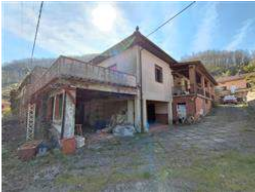
vista complessiva del fabbricato
