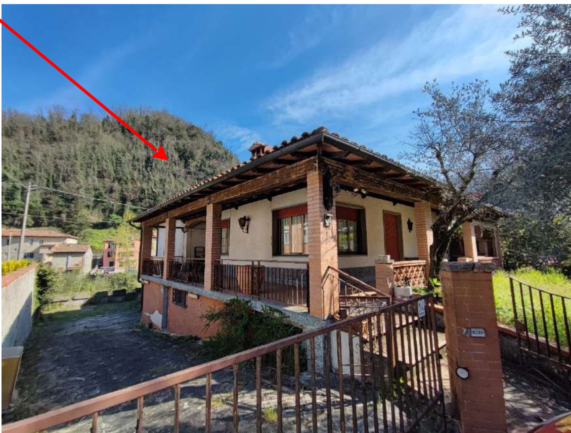
FOTO 1: Vista da nord - individuazione corpo A
