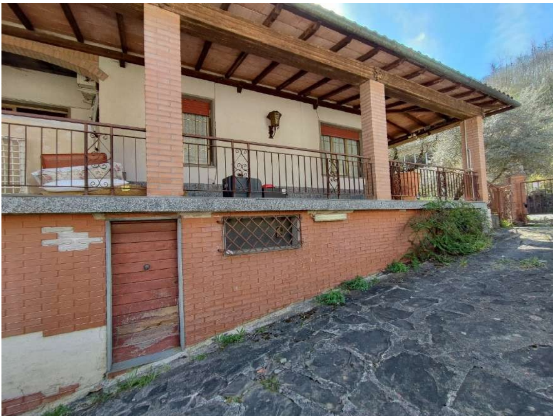
FOTO 18: Portico lato ovest ed accesso a cantina
