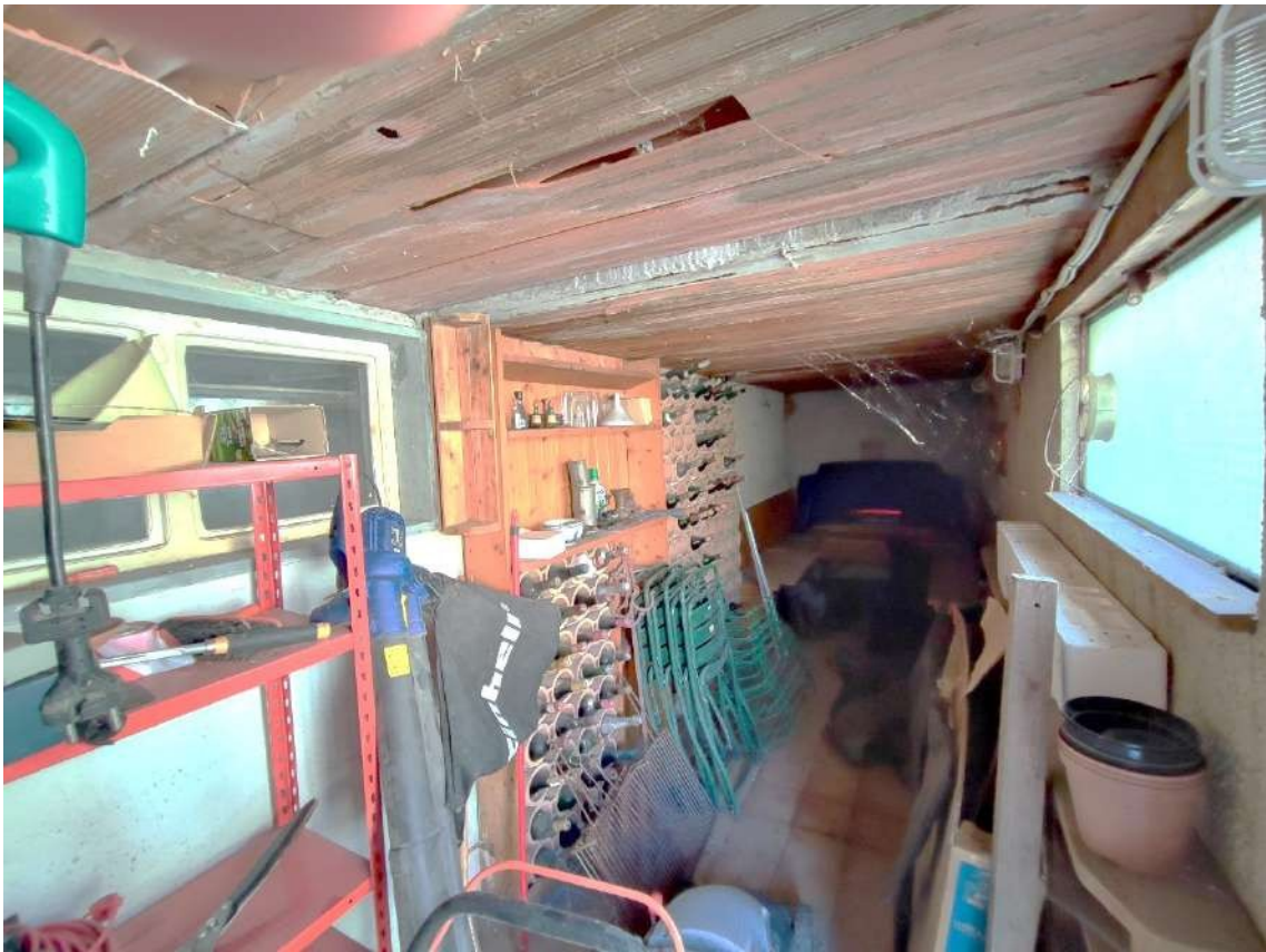
FOTO 19: Cantina a piano seminterrato
