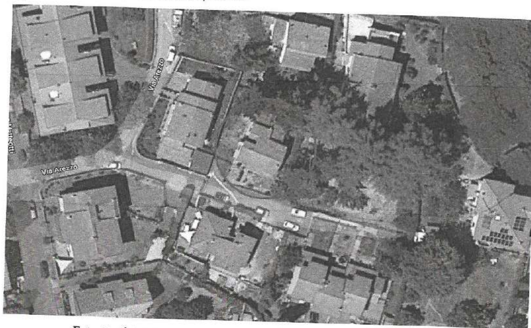
Estratto foto aerea Google Maps - Via Arezzo n. 2, Castel del Piano (GR)
