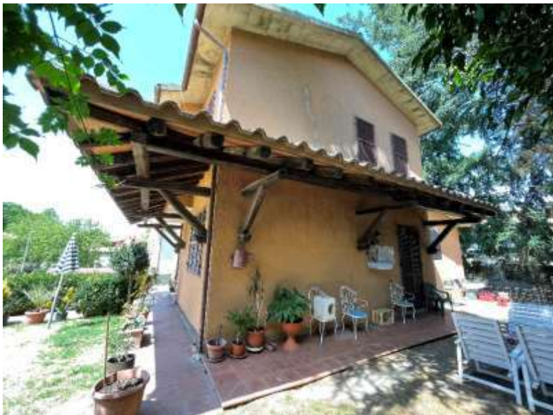
Foto 3 - Prospetto Est con secondo accesso all'abitazione Sub. 1
