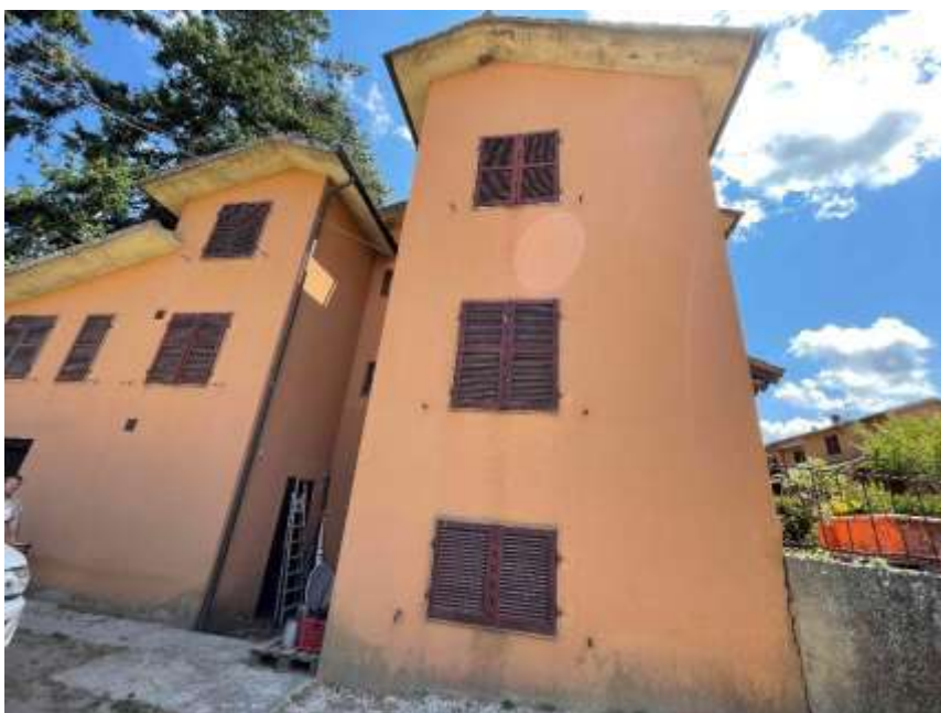
Foto 5 - Prospetto Sud con accesso locale tecnico centrale termica
