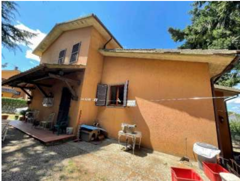
Foto 2 - Prospetto Est con secondo accesso all'abitazione Sub. 1
