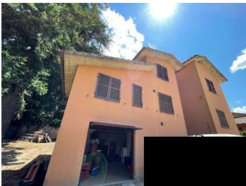
Foto 6 - Prospetto Sud con accesso locale autorimessa Sub. 2
