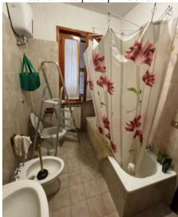
Foto 24 - Bagno piano primo Sub. 1
