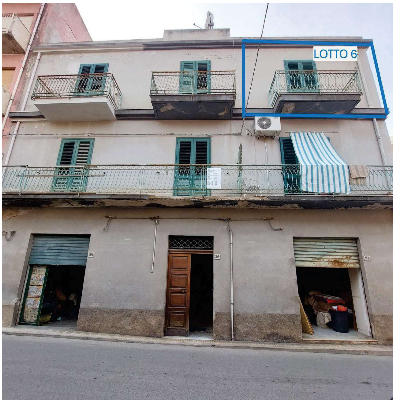
Prospetto principale - via Trento
