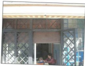
foto 04 - infisso e vetrocemento della cucina visti dal giardino
