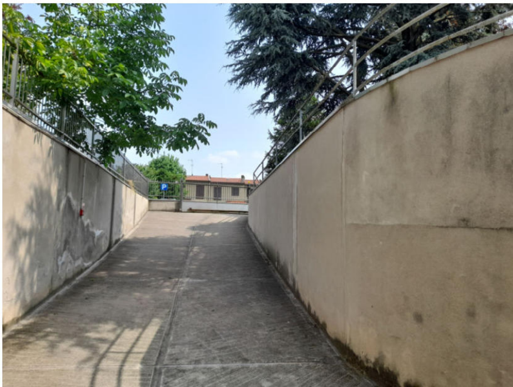
Rampa scivolo ingresso carraio
