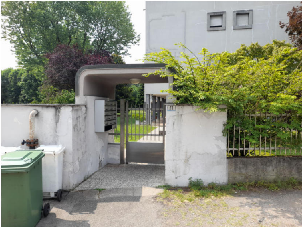
Ingresso pedonale da via G. Pascoli
