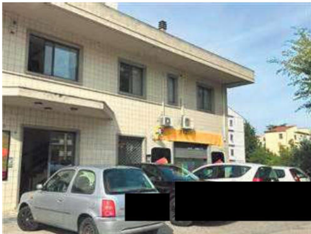
esterno - lato ingresso
