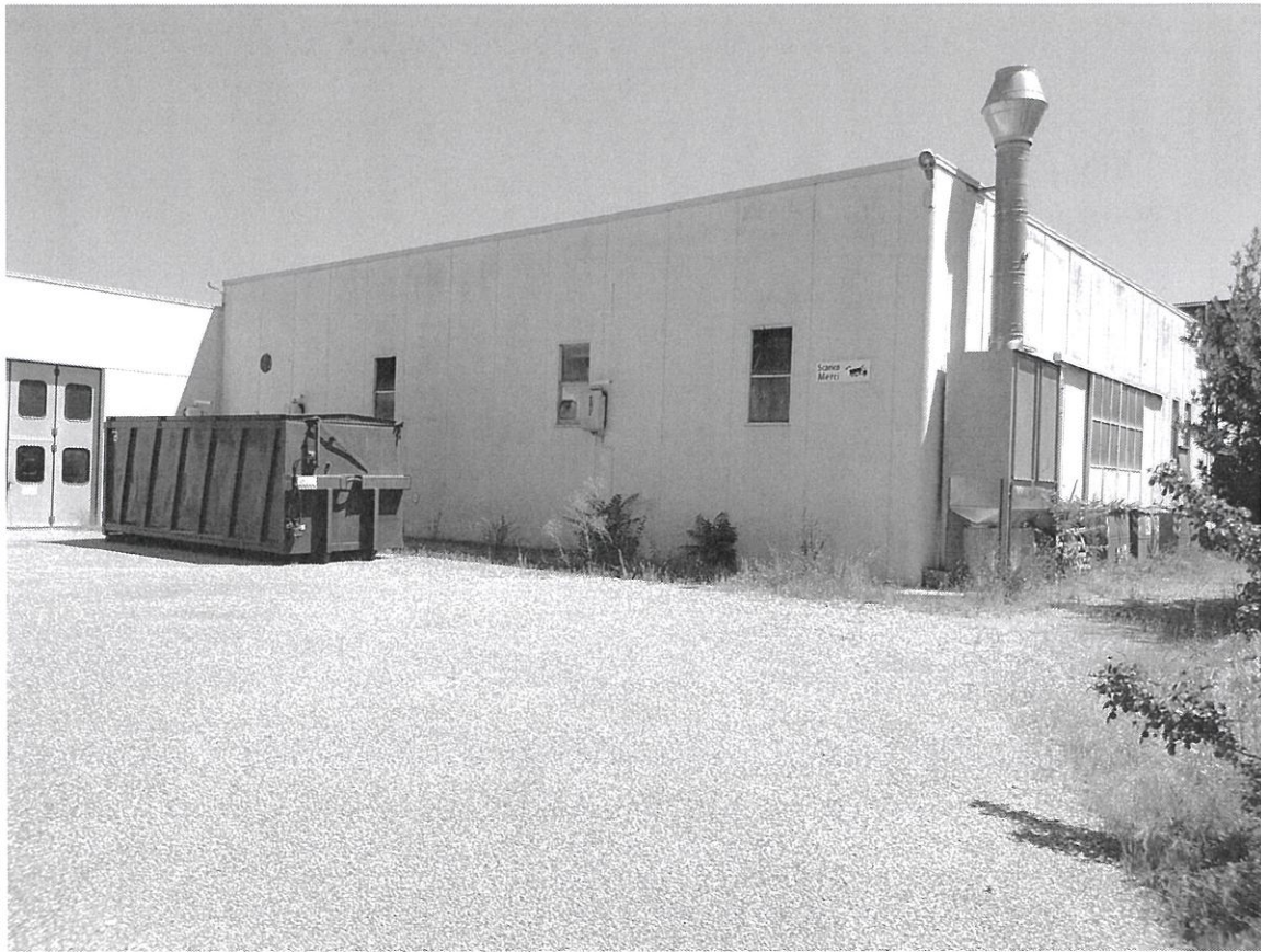
RESEDE INTERNO TRA I 3 CAPANNONI VISTA SULLA "ZONA 4"
