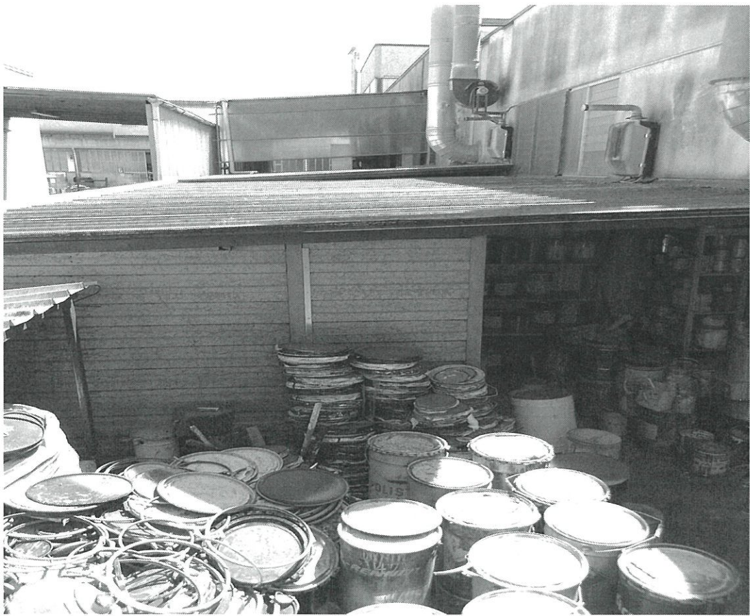
RETRO CAPANNONIDEPOSITO VERNICI E SOLVENTI ZONA 6 DA DEMOLIRE
