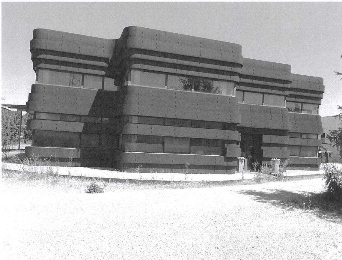
FRONTE PRINCIPALE UFFICI
