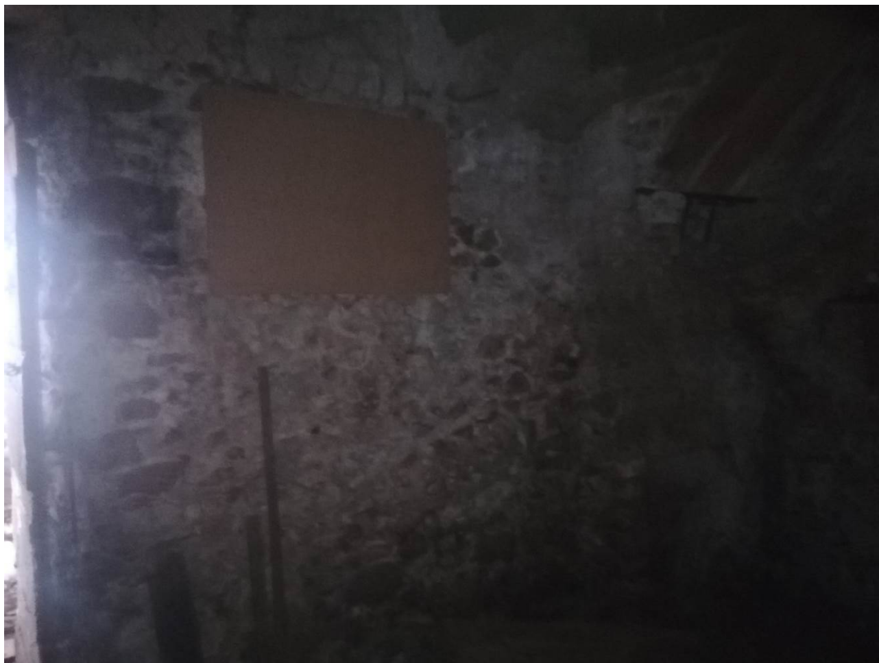
Foto 7 – interno – vano finestra
