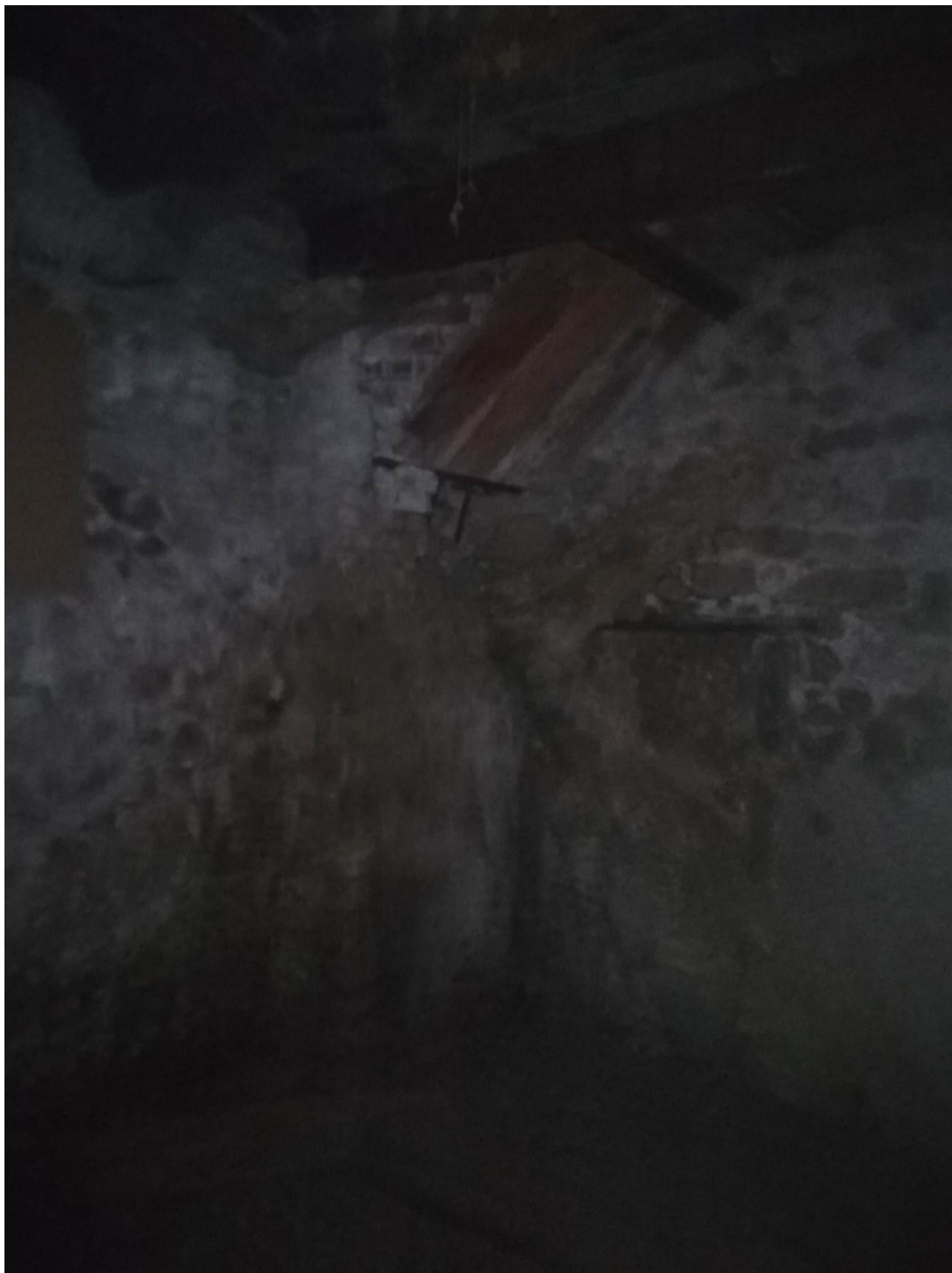
Foto 5 – interno verso sinistra
