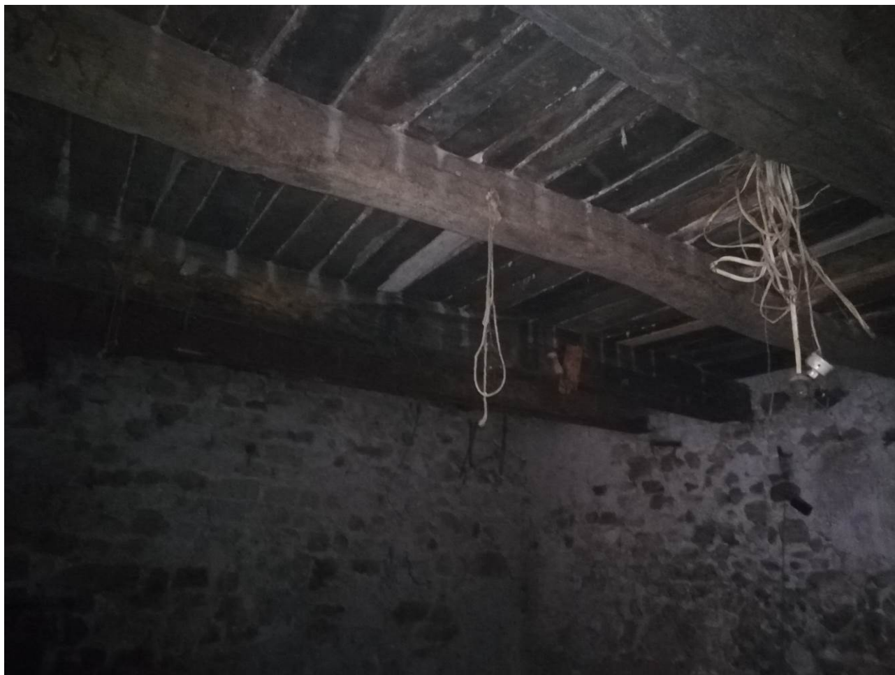
Foto 6 – interno angolo sinistro
