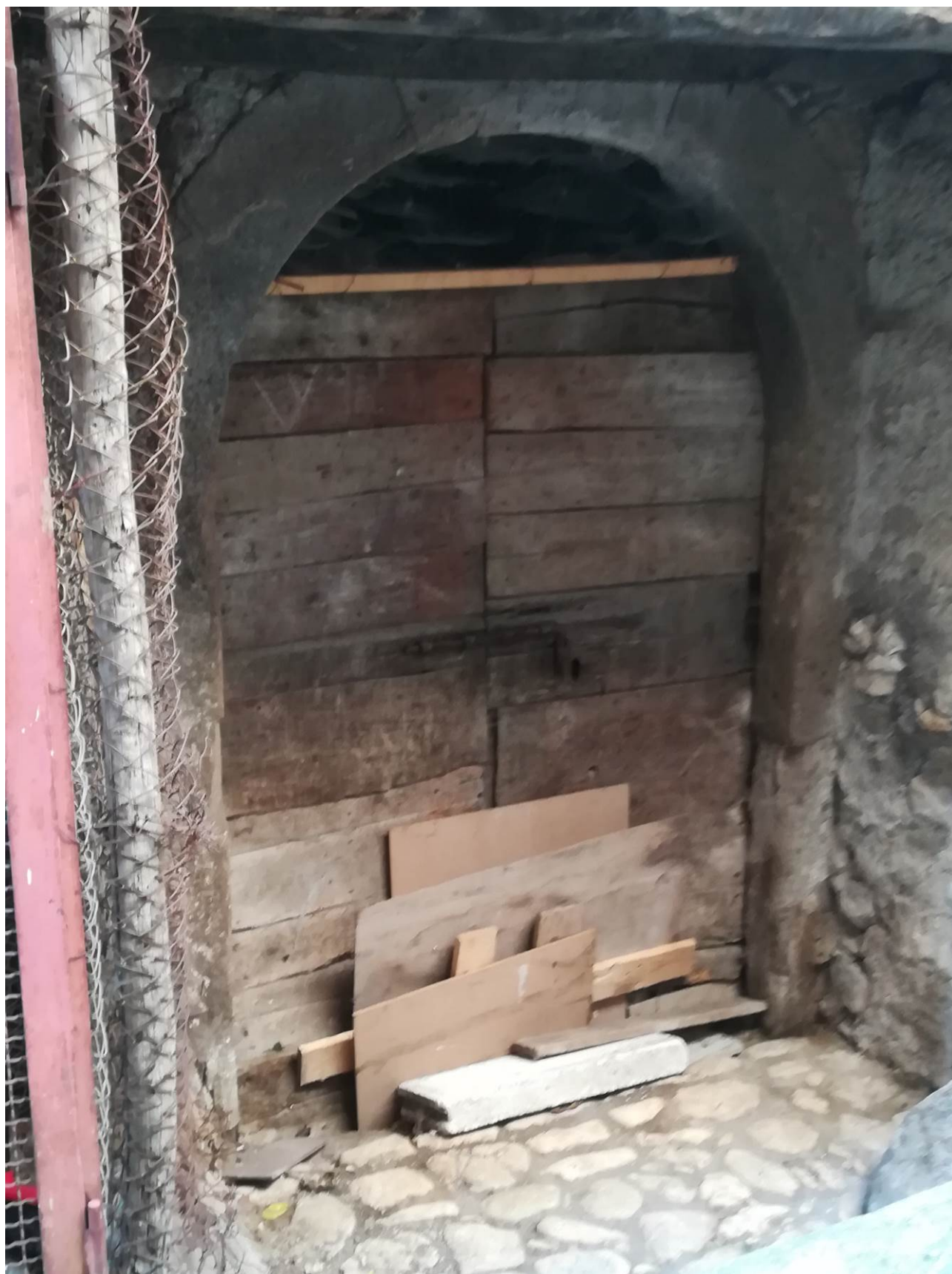
Foto 2 – porta di ingresso
