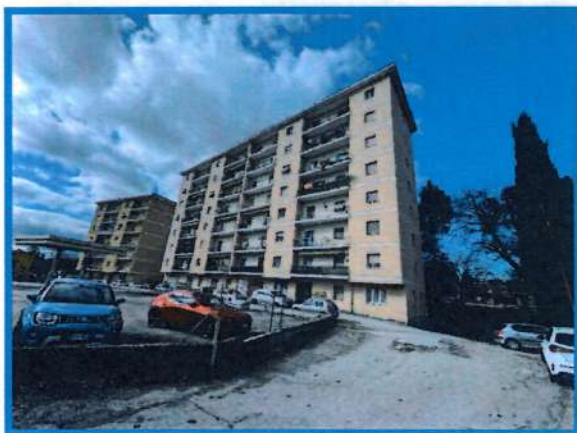
FRONTE ANTERIORE FABBRICATO
