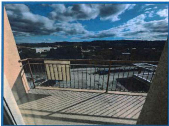
BALCONE SU FRONTE ANTERIORE
