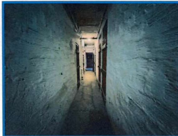
CORRIDOIO DI ACCESSO ALLE CANTINE
