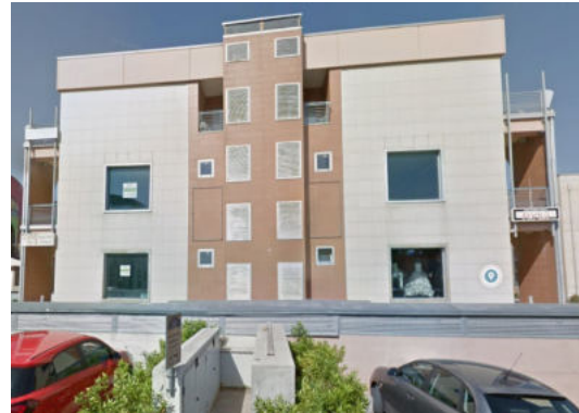
Prospetto laterale sinistro
