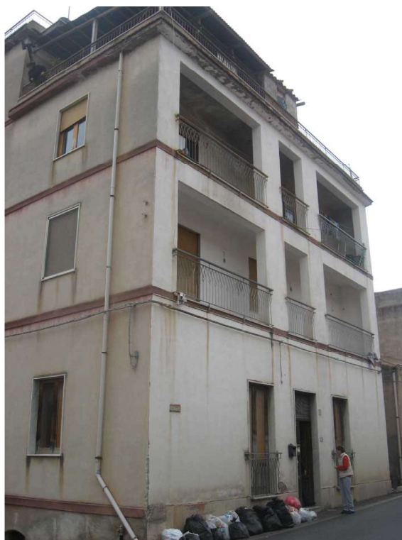
Foto N° 1 Unità immobiliare in Via Nazionale– Fl 13 part.IIa 223 sub 13 – Prospetto principale
