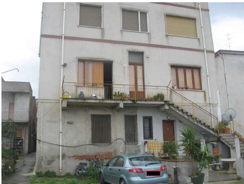
Foto N° 2 Unità immobiliare in Via Nazionale– Fl 13 part.IIa 223 sub 13 – Prospetto retro
