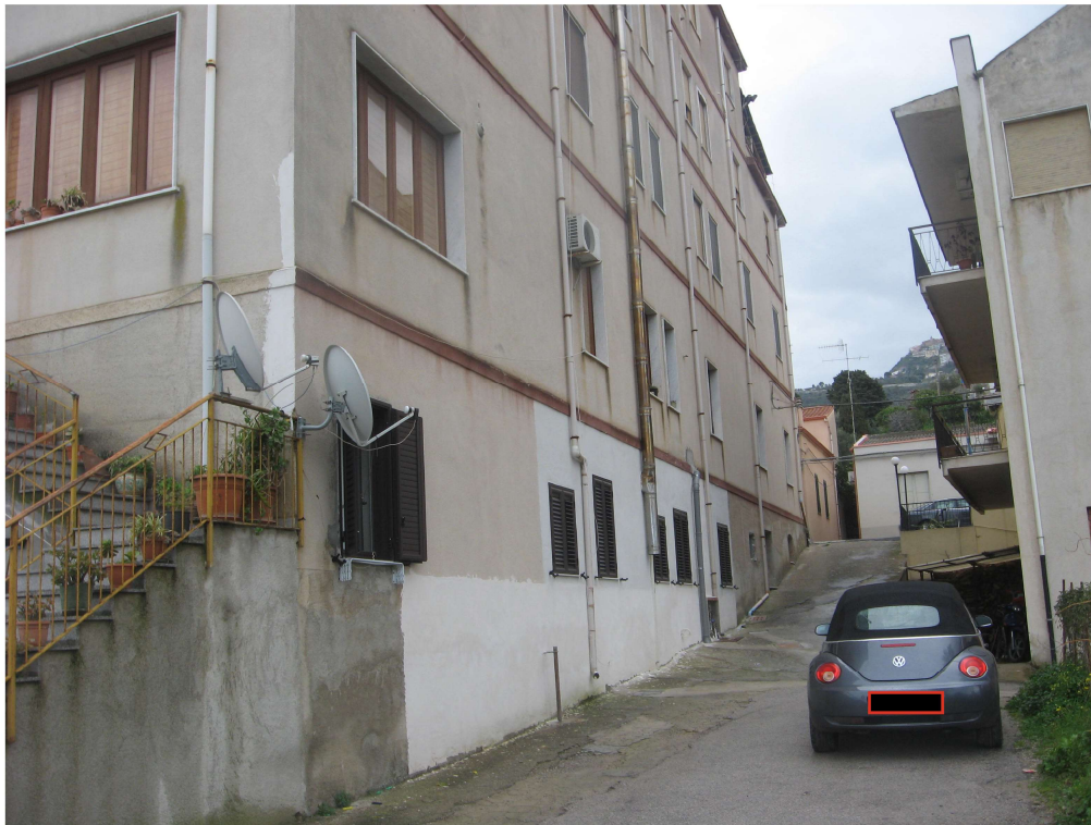
Foto N° 2 Unità immobiliare in Via Nazionale– Fl 13 part.Ila 223 sub 14 – prospetto laterale
