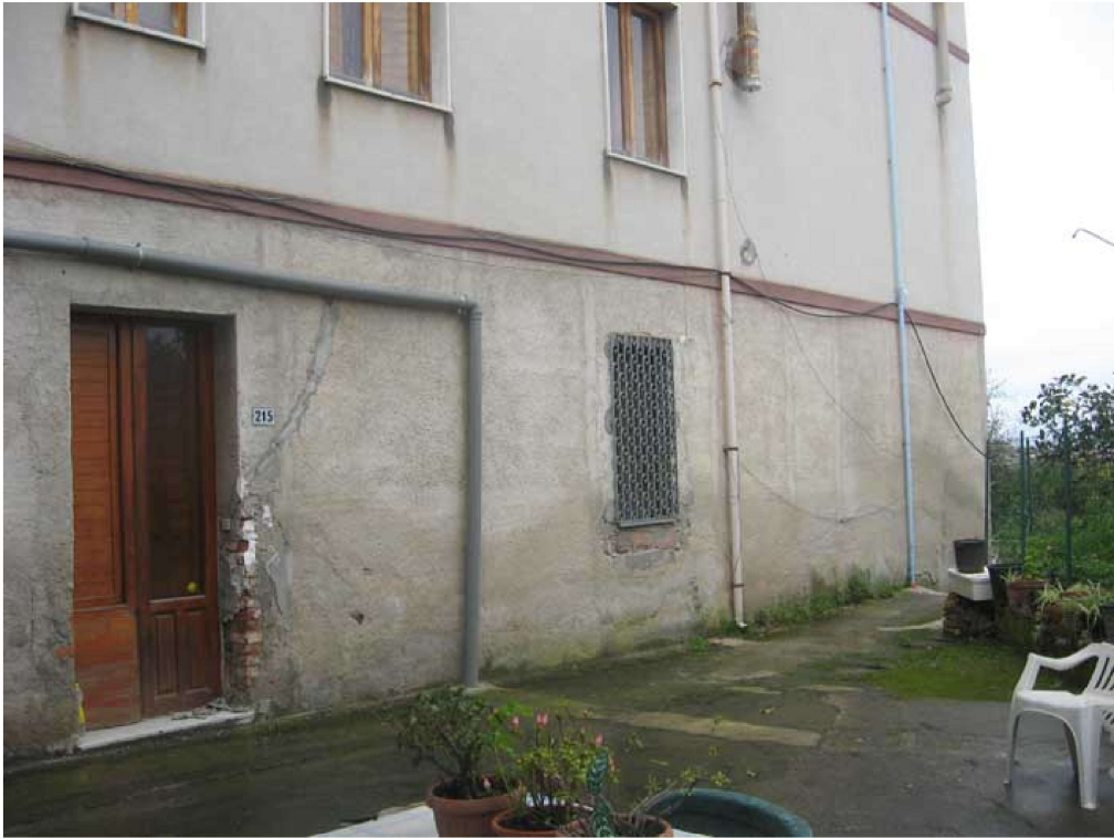
Foto N° 1 Unità immobiliare in Via Nazionale– Fl 13 part.Ila 223 sub 9 – Prospetto esterno
