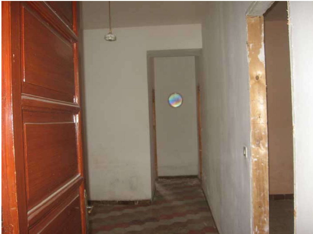
Foto N° 2 Unità immobiliare in Via Nazionale– Fl 13 part.Ila 223 sub 9 – Disimpegno
