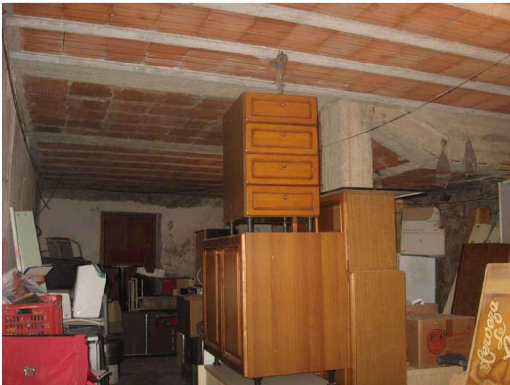
Foto N° 2 Unità immobiliare in Via Nazionale– Fl 13 part.IIa 223 sub 4 - Stanza
