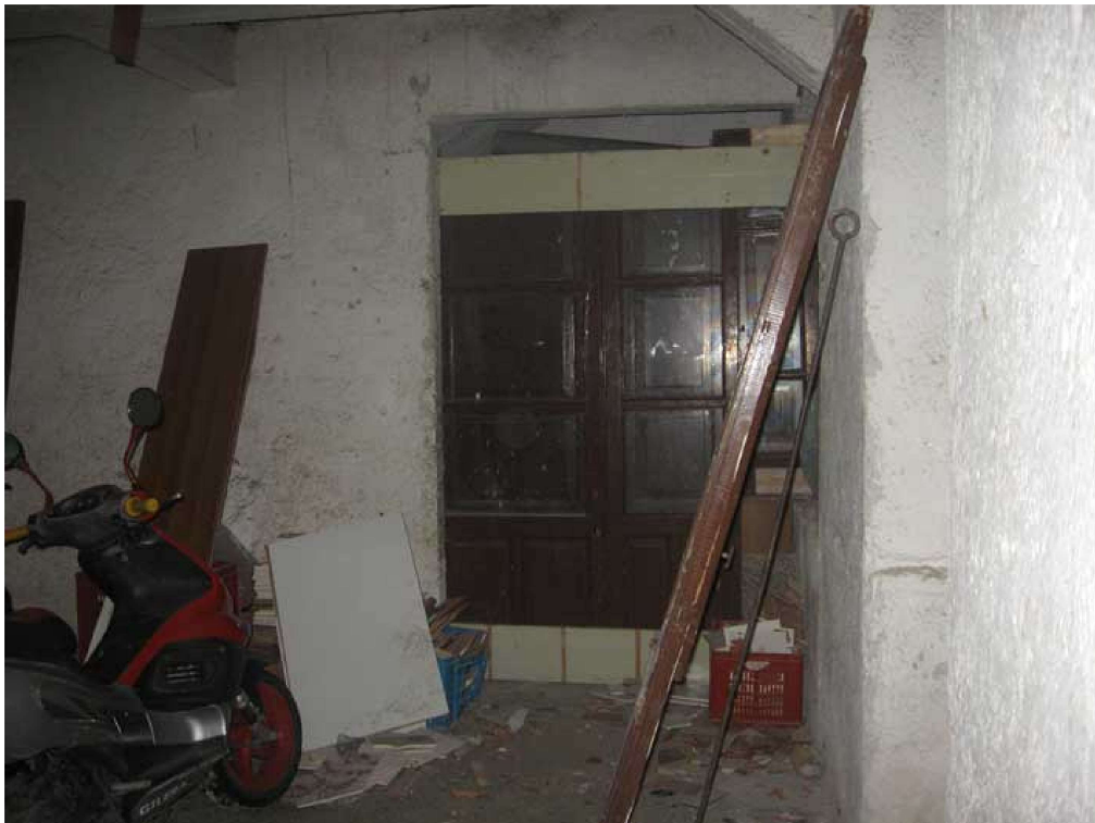
Foto N° 4 Unità immobiliare in Via Nazionale– Fl 13 part.IIa 223 sub 4 – stanza
