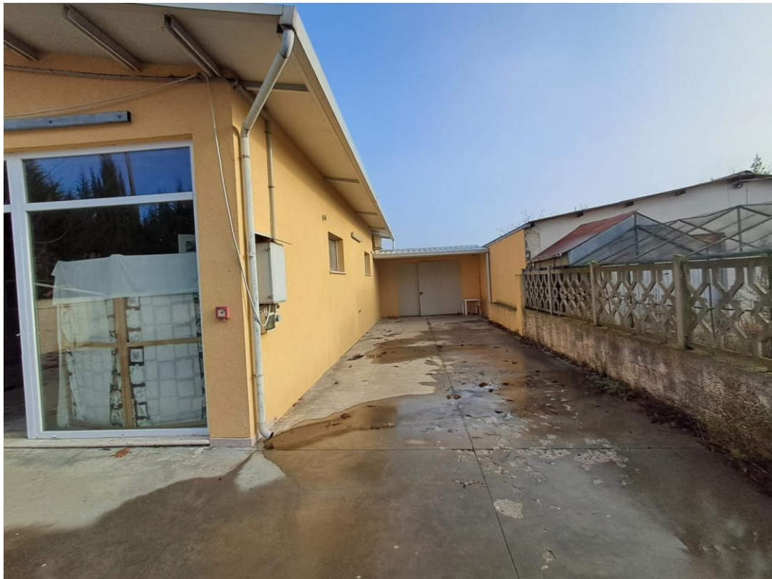
Foto 10: PART.LLA 292 ESTERNO VISTA LATERALE.
