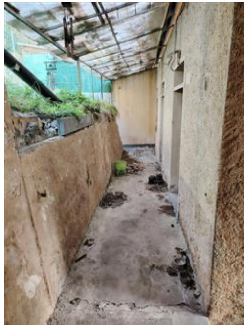
marciapiede d'accesso all'immobile
