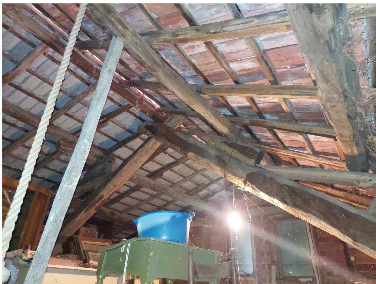
FOTO 16,17,18: scala di accesso al sottotetto e vano sottotetto
