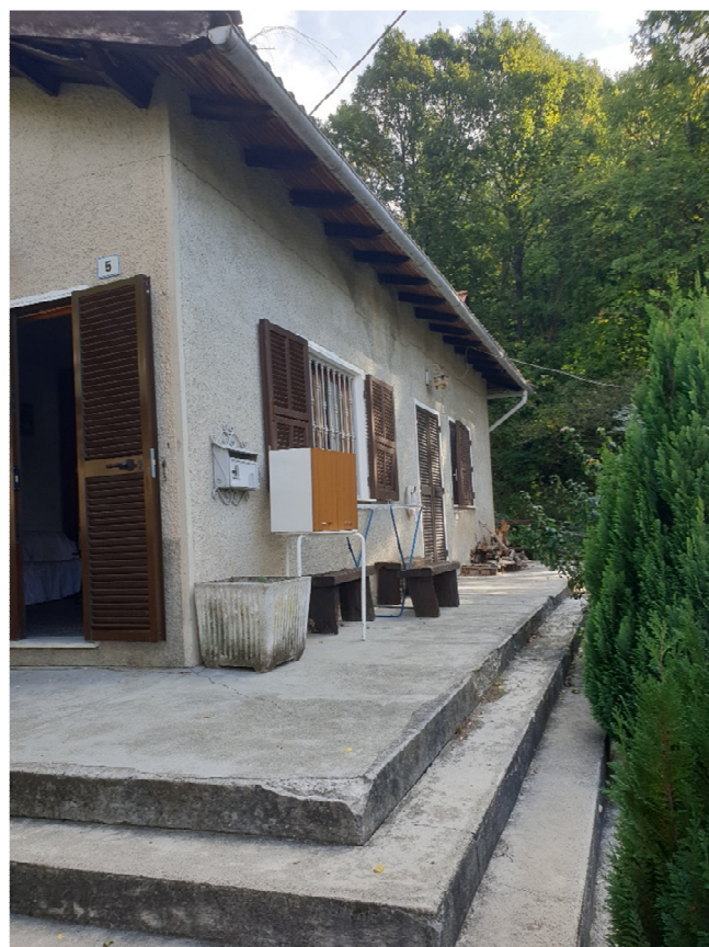
FOTO 40: vista del prospetto sud
