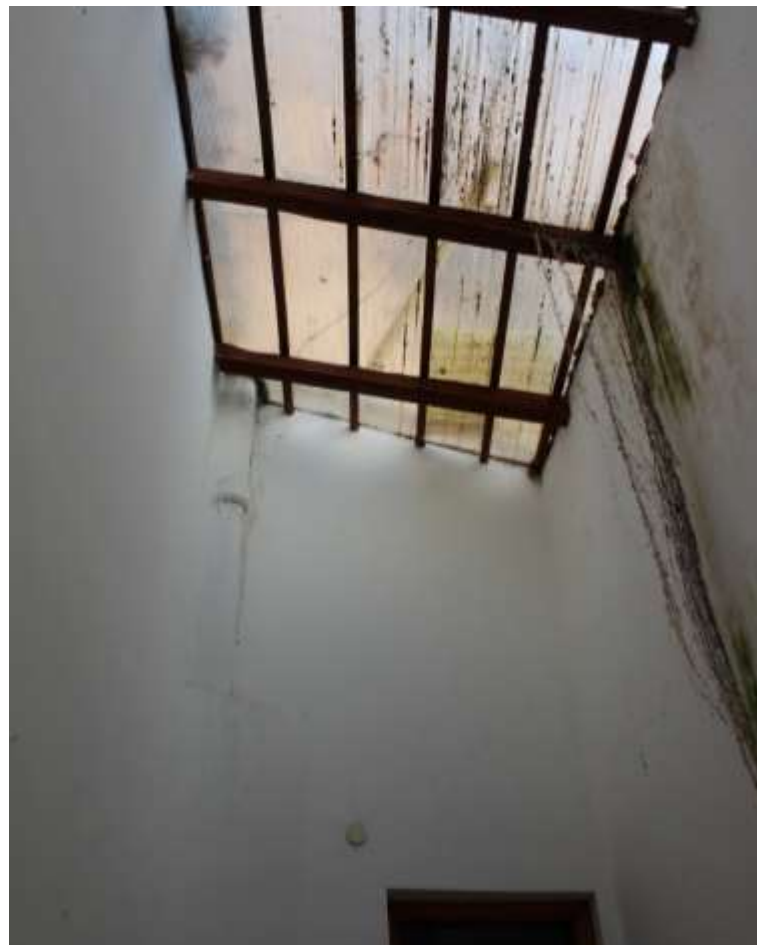
FOTO 12 – Copertura vano scala
