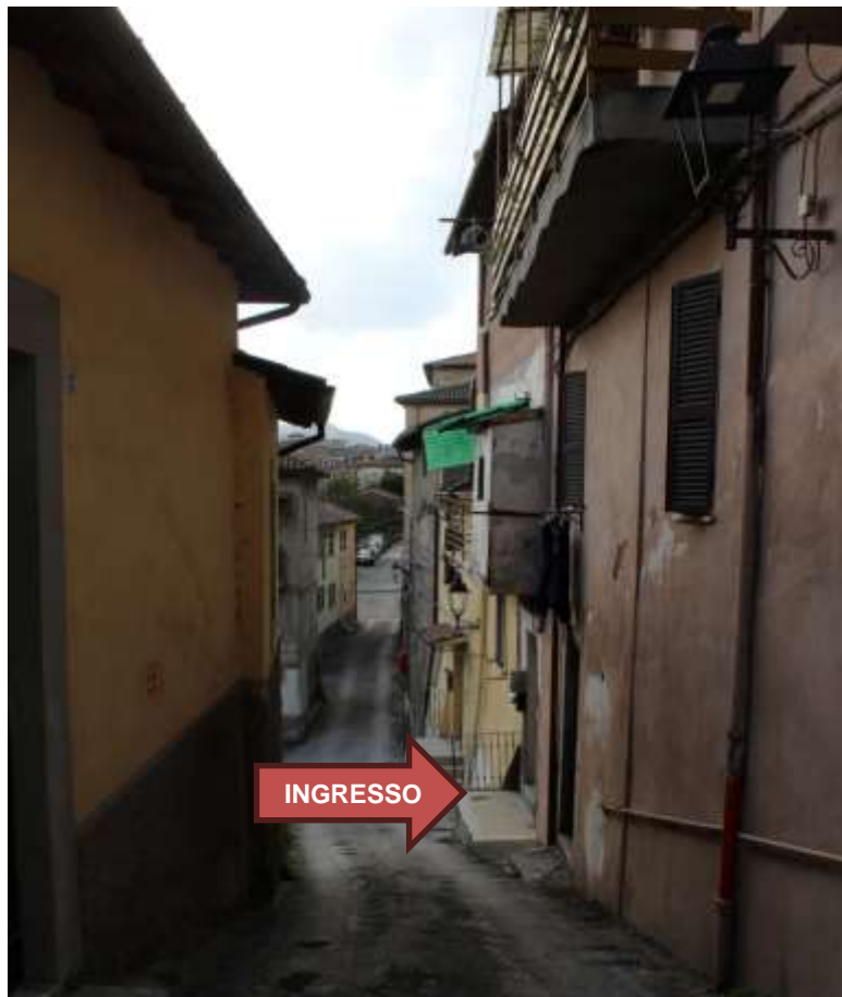
FOTO 3 - Vista esterna su Via dei Pozzi
