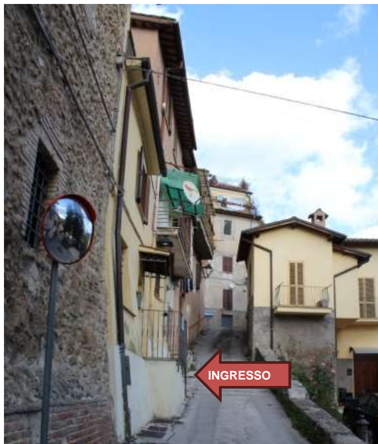
FOTO 2 – Vista esterna su Via dei Pozzi
