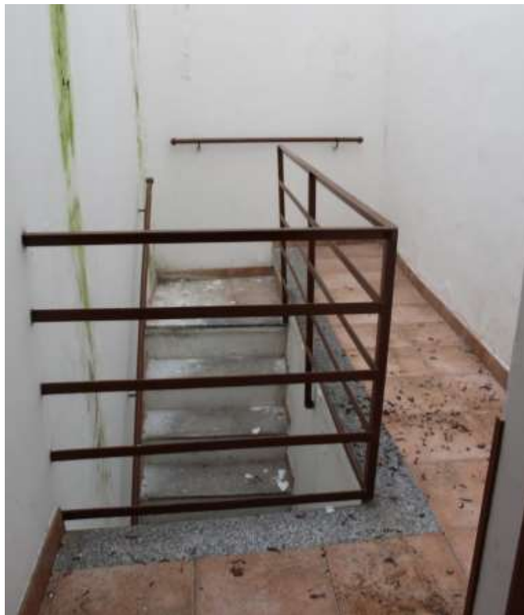
FOTO 11 – Vano scala (Piano Primo)
