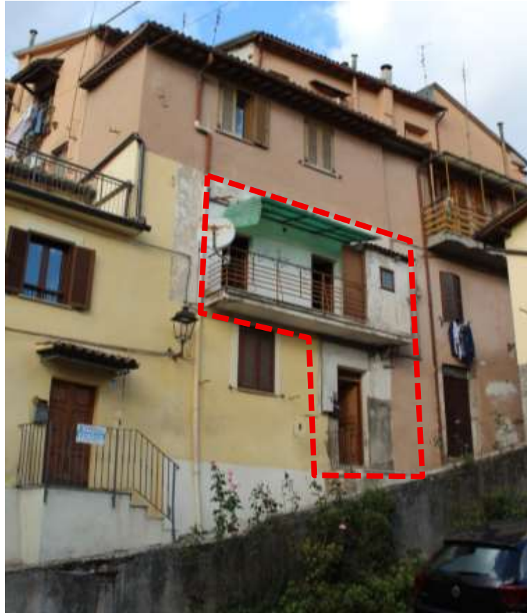
FOTO 1 – Vista esterna lato Sud
