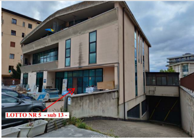
Prospetto intero edificio lungo via C. Renzi
