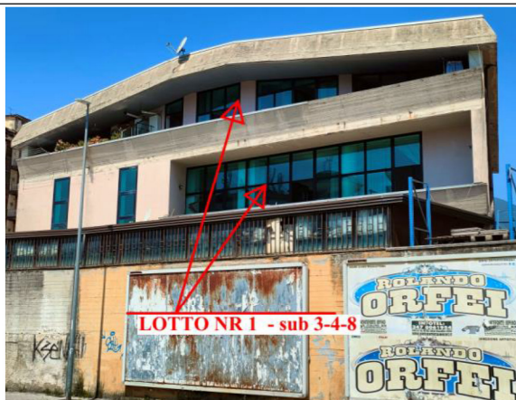
Prospetto intero edificio lungo via Vallone dei Lupi
