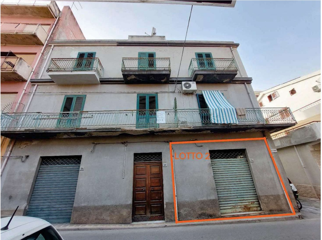
Prospetto principale Via Trento n. 24
