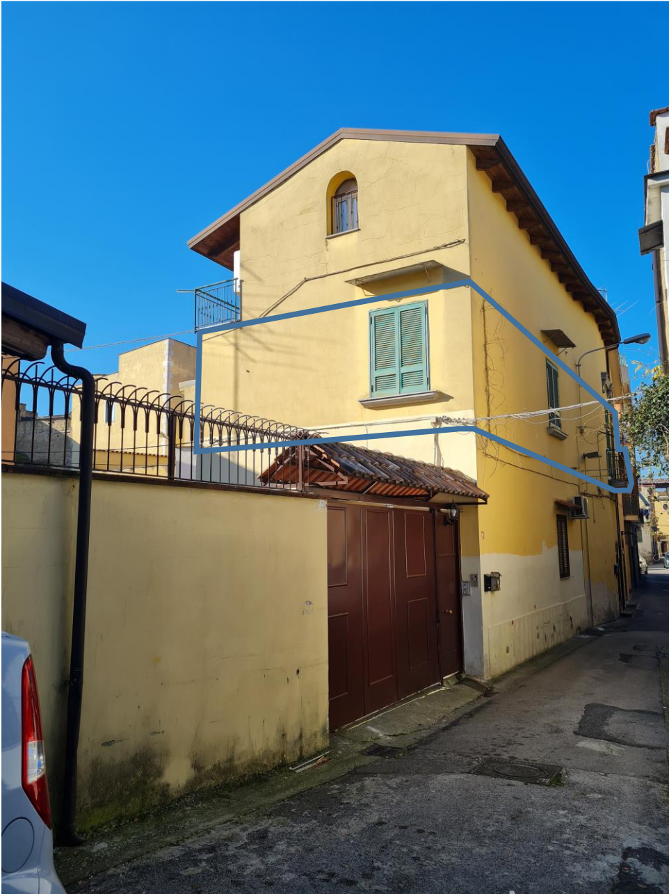
Vico Pragliuli 26, in evidenza il piano primo sottoposto a pignoramento sub 13
