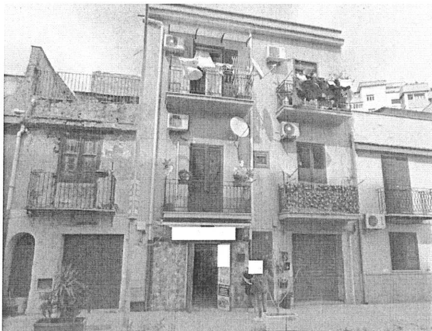
Figura 5: Ripresa del prospetto sulla Via Principe di Palagonia del fabbricato in cui sorge l'immobile
