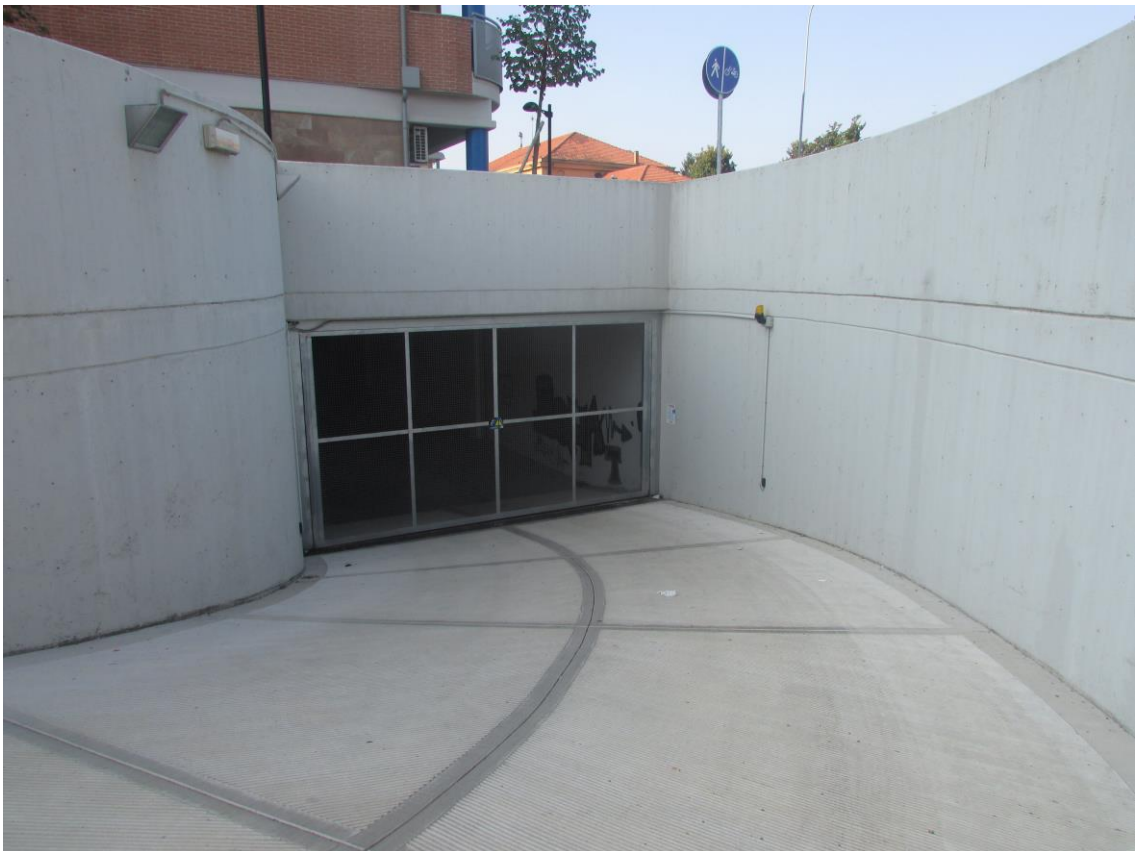
Ingresso comune garages
