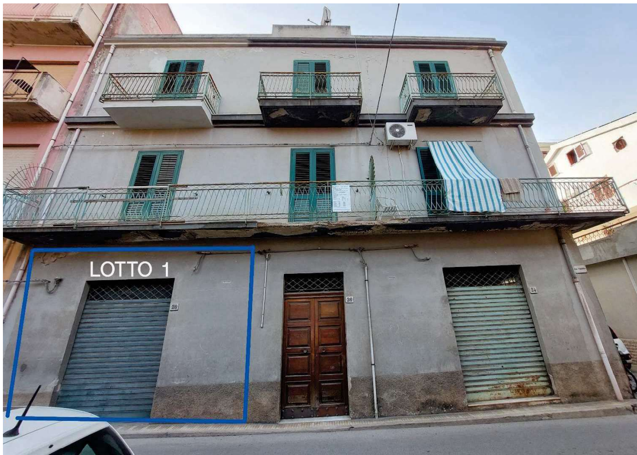
Prospetto principale Via Trento n. 28
