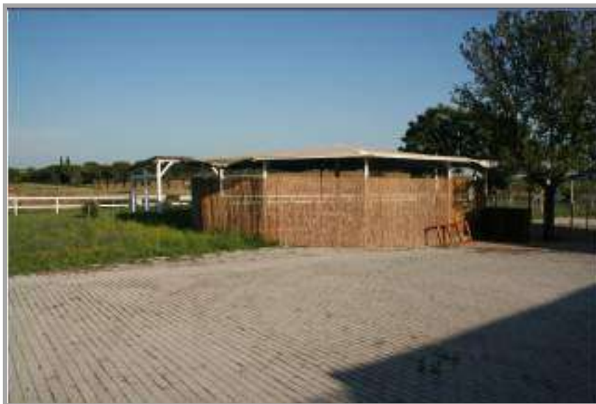
Foto “ 10 ” – Vista del gazebo esterno adibito a braceria NOTA si veda non conformità in relazione
