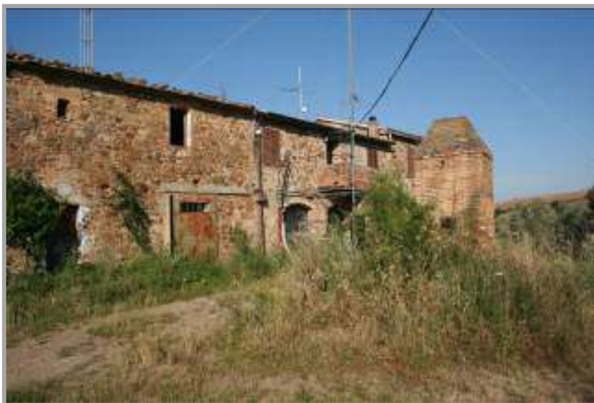
Foto “ 14 ” – Vista degli immobili rurali F 25 Part. 45 Sub 1 e 2 Catasto Terreni
