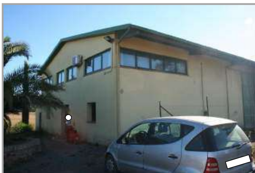
Foto “ 18 ” – Vista dell’area adibita a uffici e magazzino
