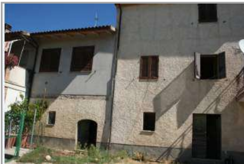
Foto " 31 " – Vista dell'immobile F. 23 Part. 3 Sub 4, 5, 6 e 7
