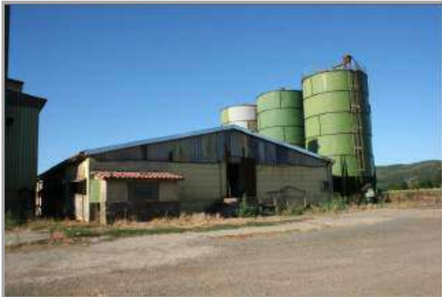
Foto “ 26 ” – Vista dell’area produttiva
