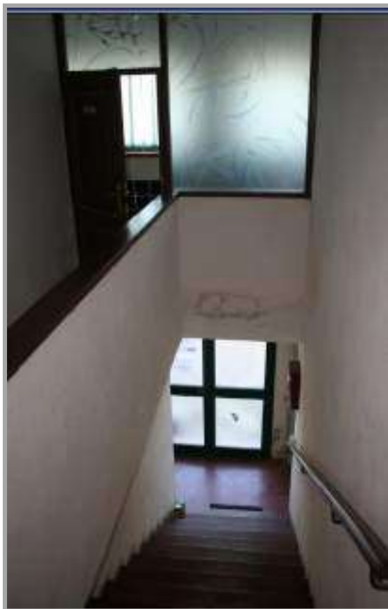
Foto “ 21 ” – Vista della scala di accesso al piano primo
