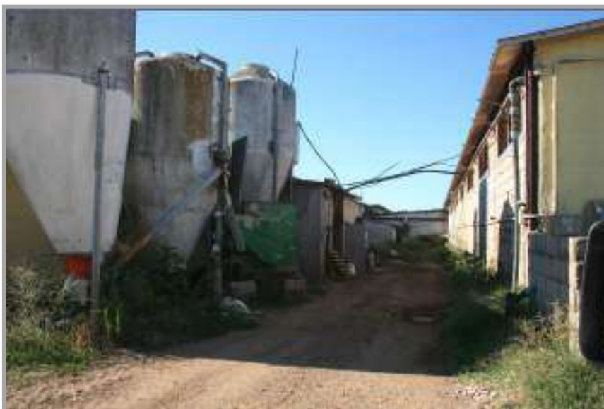
Foto “ 23 ” – Vista dell’area produttiva
