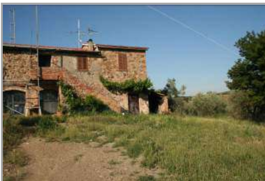
Foto “ 15 ” – Vista degli immobili rurali F 25 Part. 45 Sub 1 e 2 Catasto Terreni
