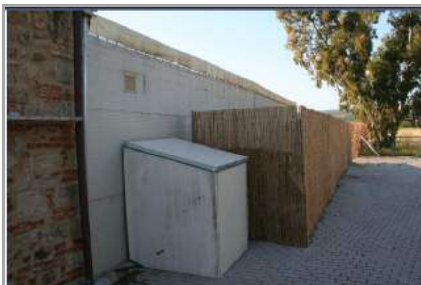
Foto " 3 " – Vista dei manufatti in telonato con struttura di sostegno in metallo leggera NOTA si veda non conformità in relazione
