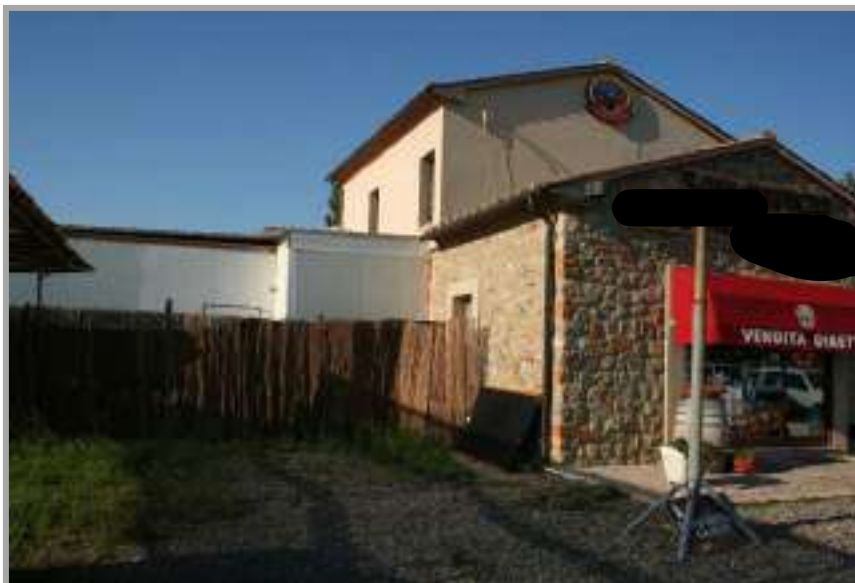
Foto " 4 " – Vista dell'edificio principale edei manufatti in telonato con struttura di sostegno in metallo leggera e in lamiera sandwich NOTA si veda non conformità in relazione
