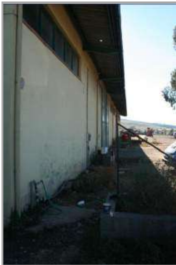
Foto " 19 " – Vista dell'area adibita a uffici e magazzino
