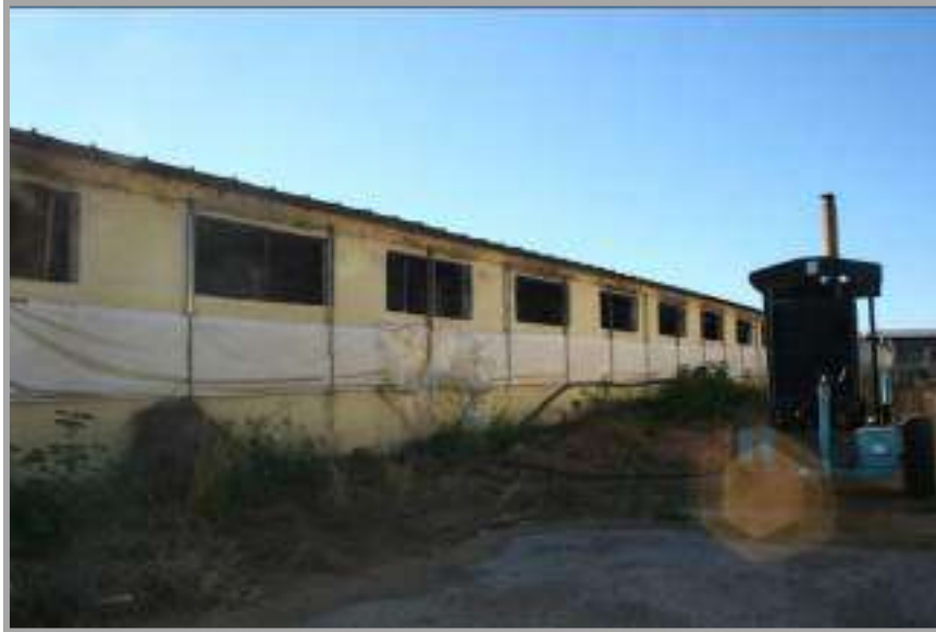
Foto “ 25 ” – Vista dell’area produttiva
