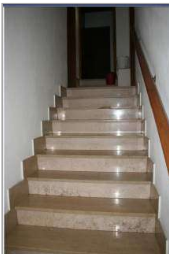
Foto “ 33 ” – Vista della scala di accesso al piano primo dell’immobile F. 23 Part. 3 Sub 4
