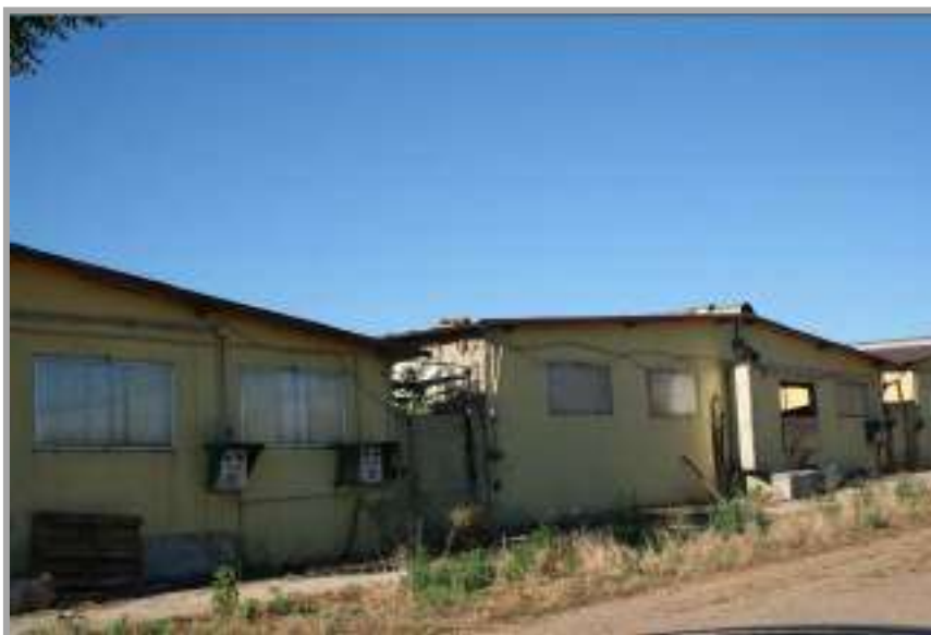
Foto “ 24 ” – Vista dell’area produttiva
