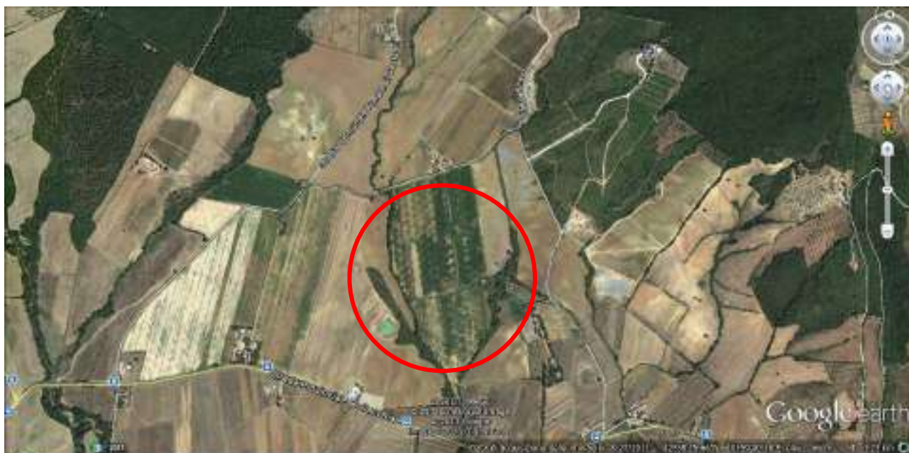
FOTO “U” – Foto Aerea con ubicazione degli immobili e dei terreni
