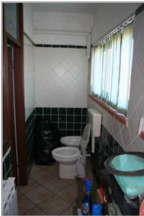
Foto “ 22 ” – Vista del bagno a servizio degli uffici
