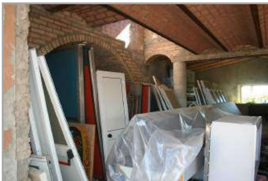
Foto " 51 " – Vista degli interni immobili F. 13 Part 16 Sub.4 e 5 in corso di costruzione
