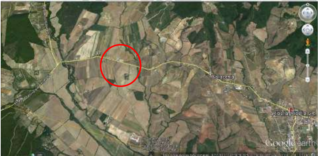
FOTO "A" – Foto Aerea con ubicazione dell'immobile e dei terreni
