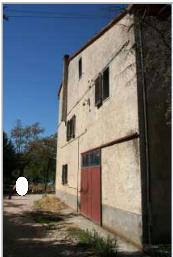
Foto " 41 " – Vista dell'ingresso immobile F. 23 Part. 3 Sub 5
