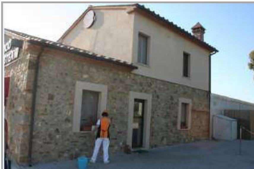
Foto " 2 " – Vista del prospetto Est dell'immobile
