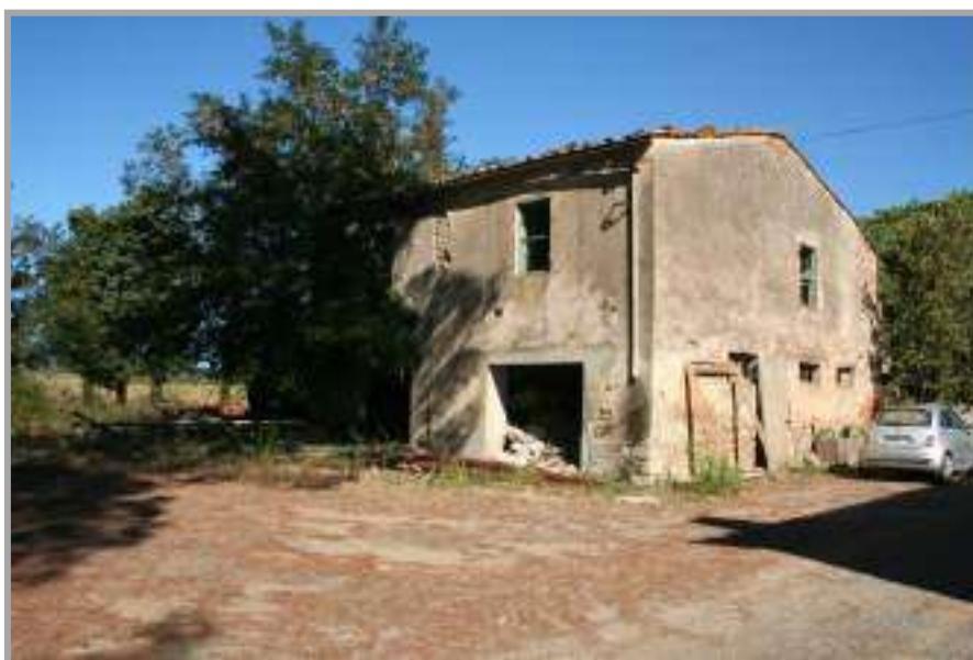
Foto “ 45 ” – Vista dell’immobile al F. 13 Part 16 Sub 2 Fabbricato B
