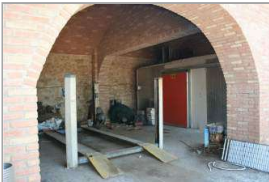
Foto " 49 " – Vista degli interni immobili F. 13 Part 16 Sub.4 e 5 in corso di costruzione
