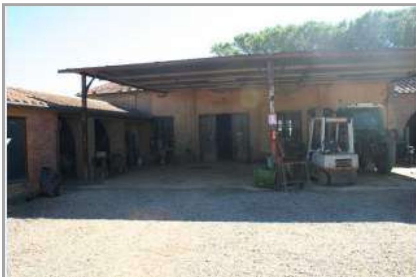
Foto " 48 " – Vista dell'immobile al F. 13 Part 16 Sub 2 Fabbricato E
