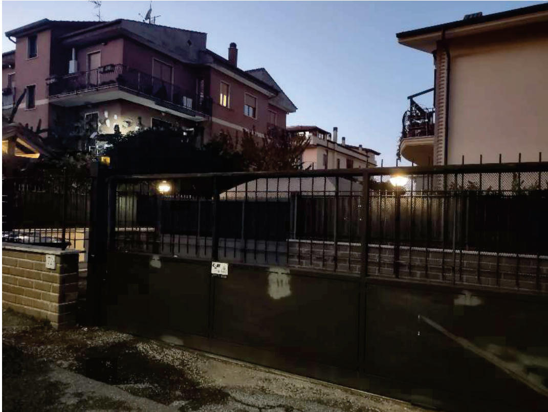
FIGURA 3: Cannello carrabile automatizzato per l'accesso al civico n. 72 di via Motta Sant'Anastasia
