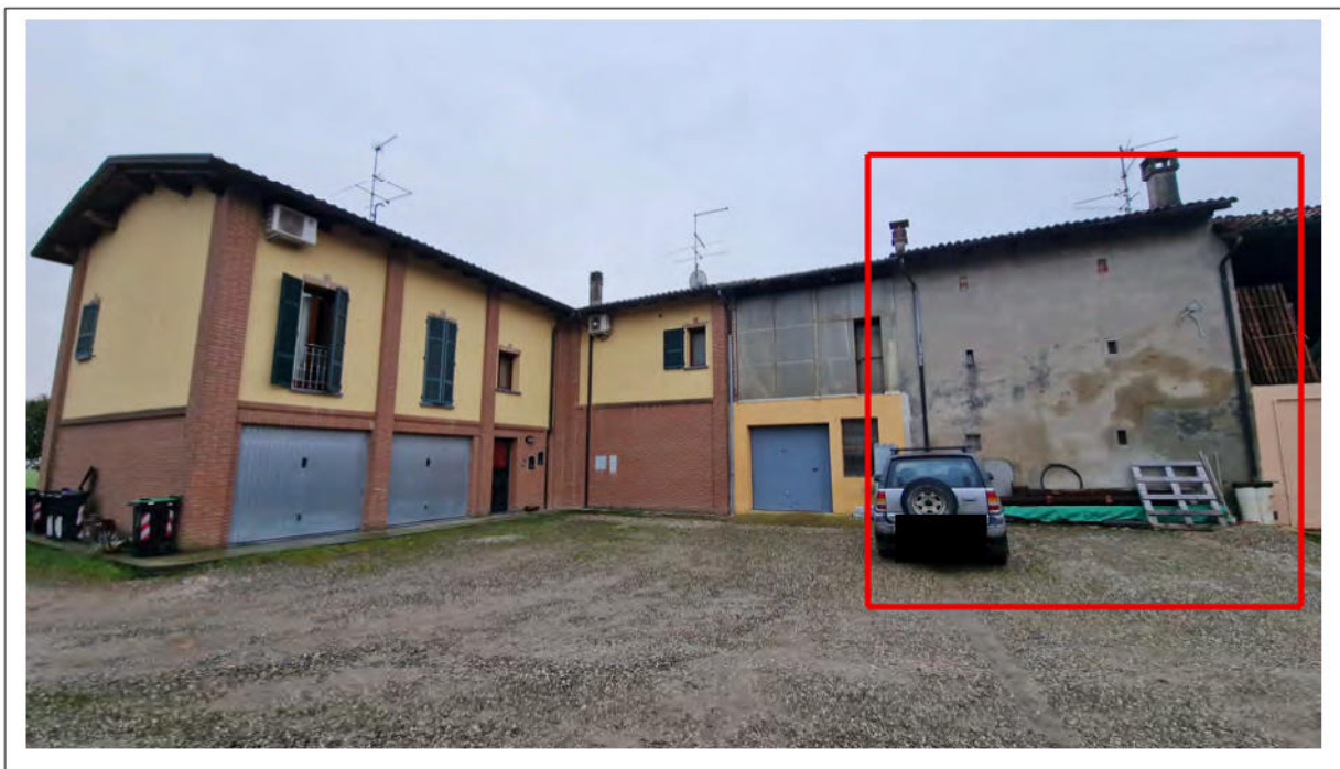
Vista del retro dalla corte esterna – fronte Est
