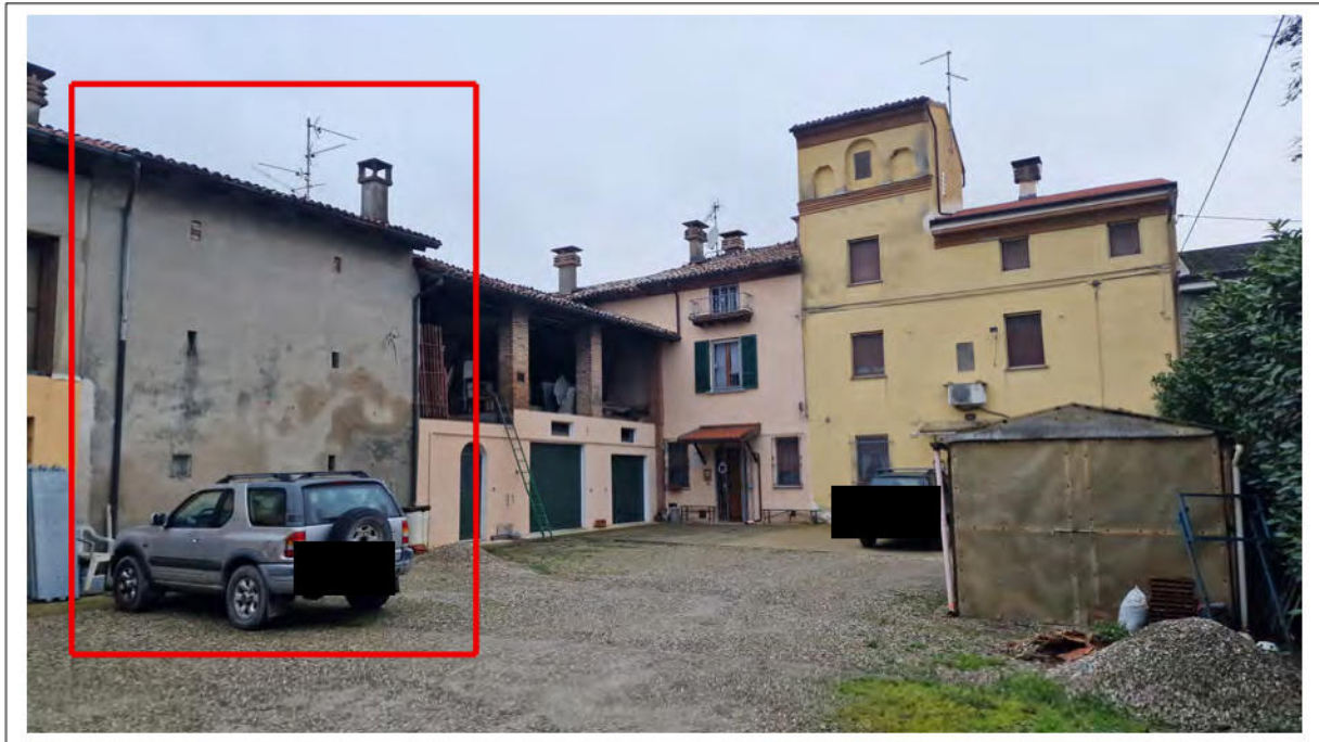
Vista del retro dalla corte esterna – fronte Est
