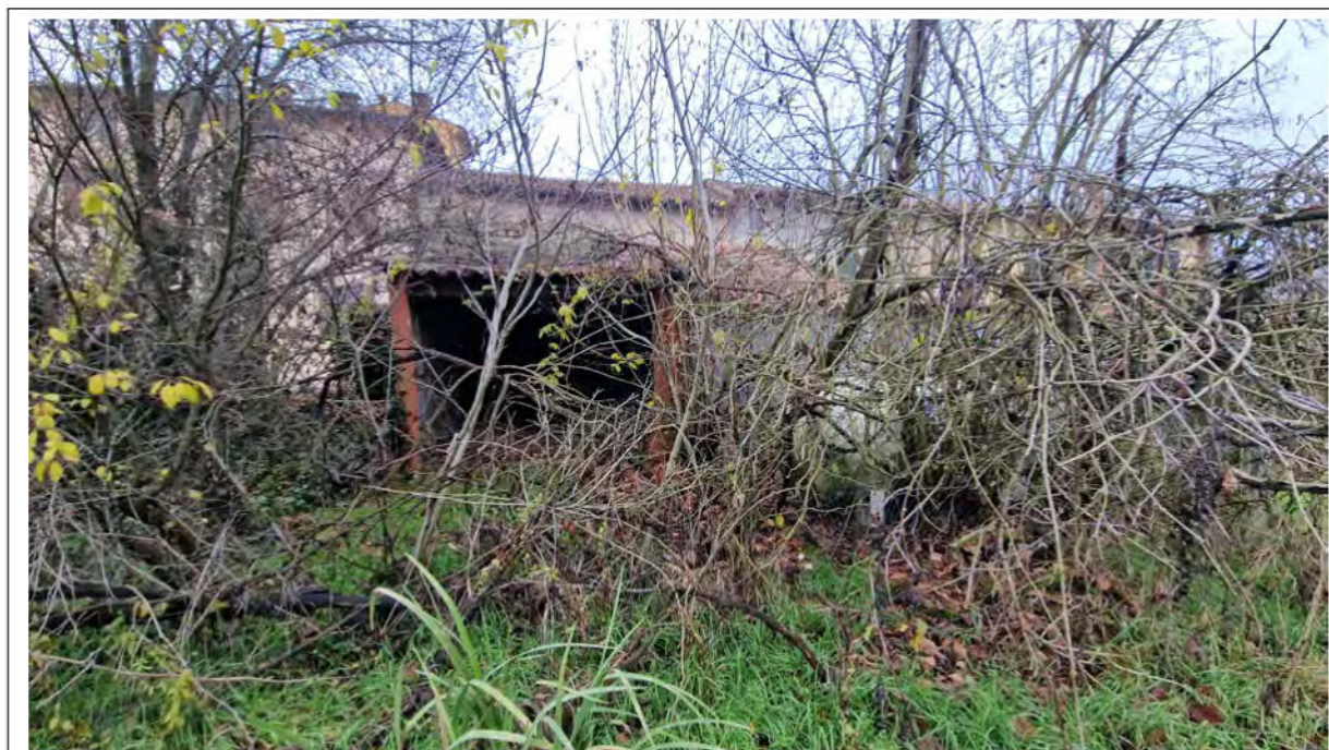
Vista dall'area pertinenziale – tettoia in lamiera da demolire
