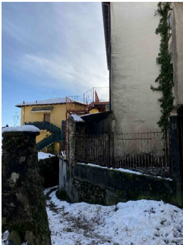
Vista strada perdonale lato nord
