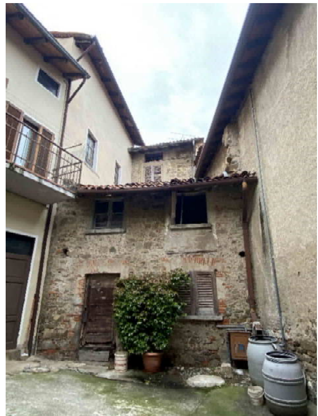
Vista cortile interno mapp 494
