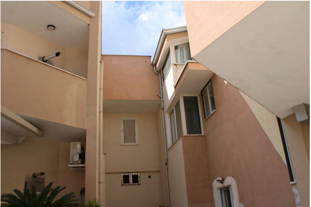
FOTO N° 19: Particella 2671 sub 14 – non commerciabile
