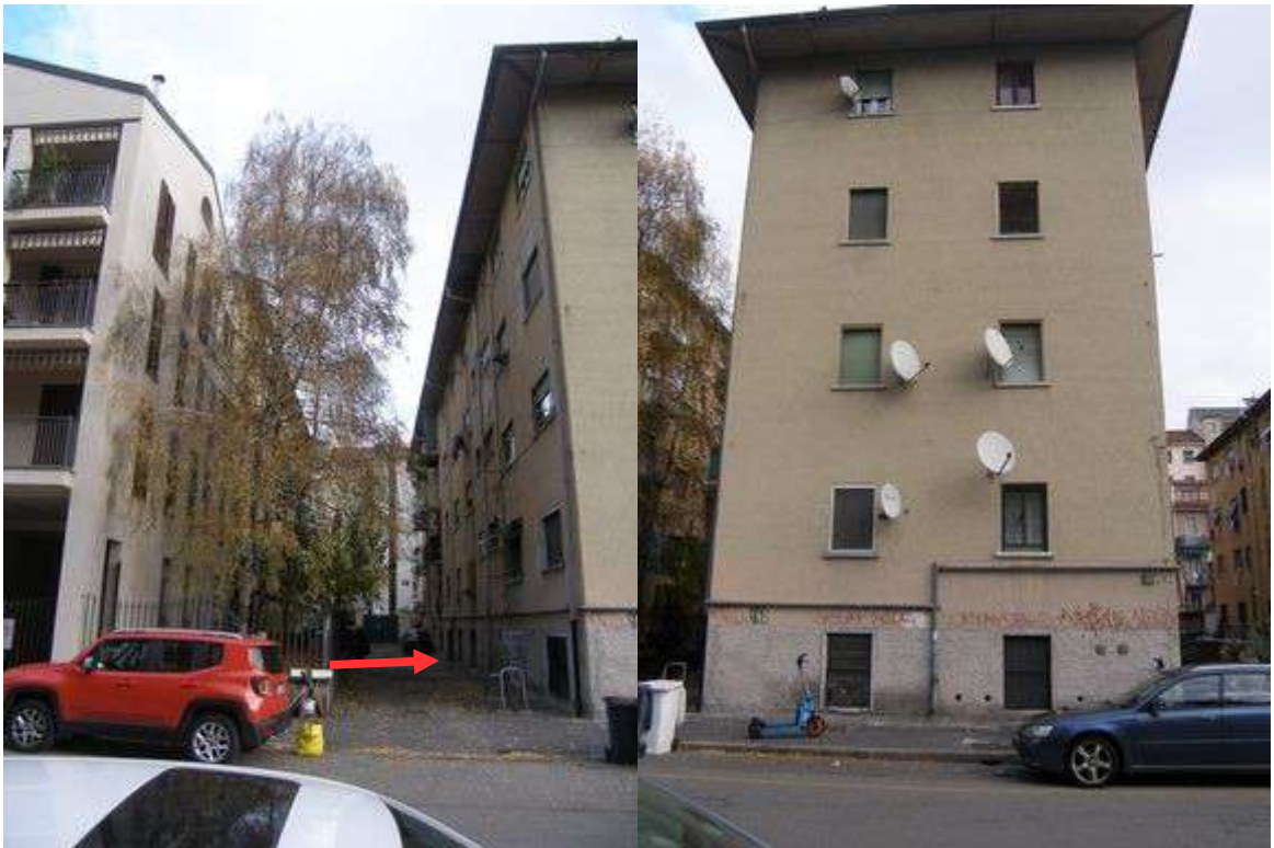
Vista fronte Sud-Ovest da via Gianicolo su strada interna tra edificio 19 e edificio 12
