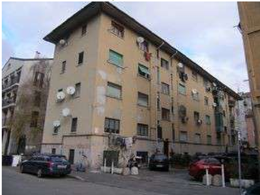
Vista fronte Nord-Est da via Gianicolo
