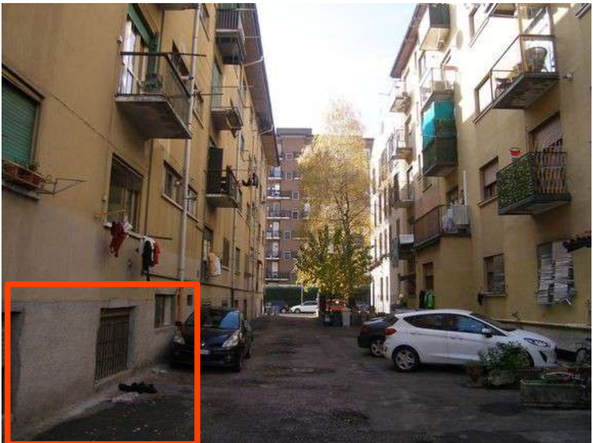
Vista fronte Sud-Ovest verso via Gianicolo da strada interna tra edificio 10 e edificio 12
