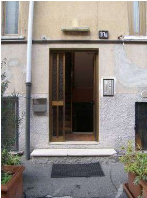
Vista porta accesso all'edificio 10 bis
