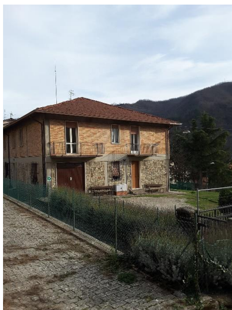
Vista esterna dell'immobile, le facciate sono in parte rivestite in pietra/sasso al piano terra e primo sottostrada ed in parte in muratura faccia vista ai piani superiori
