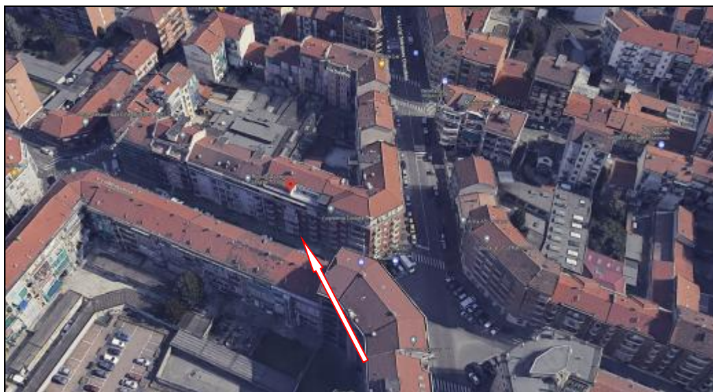
Il fabbricato - identificazione locale commerciale
