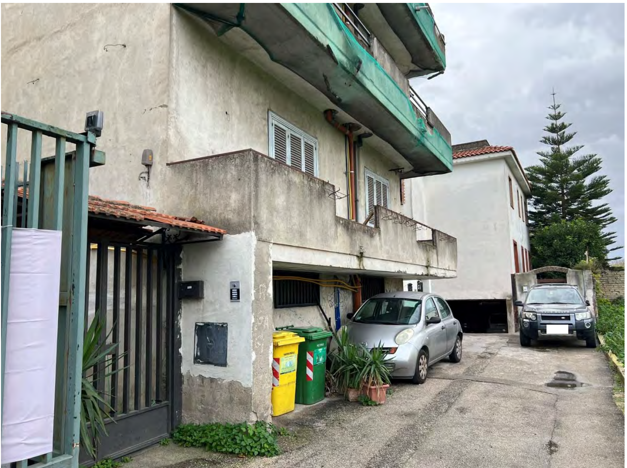
Foto 2 – Vista dell'accesso al fabbricato
