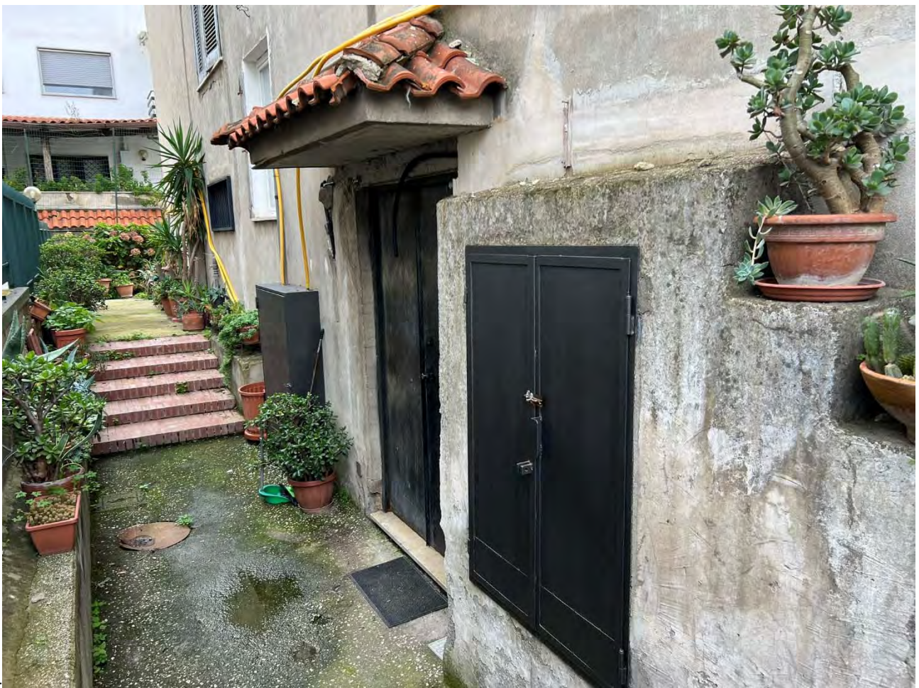
Foto 3 – Vista del tratto di area cortilizia che disimpegna l'accesso alla scala comune
