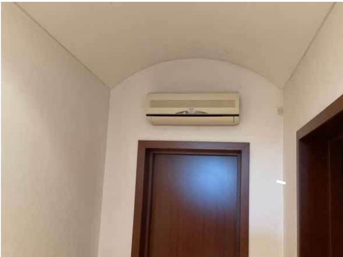
foto 74 - vista corridoio LOTTO 4
