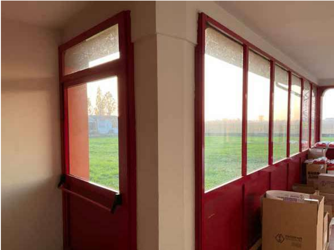
foto 59 - vista portico LOTTO 3
