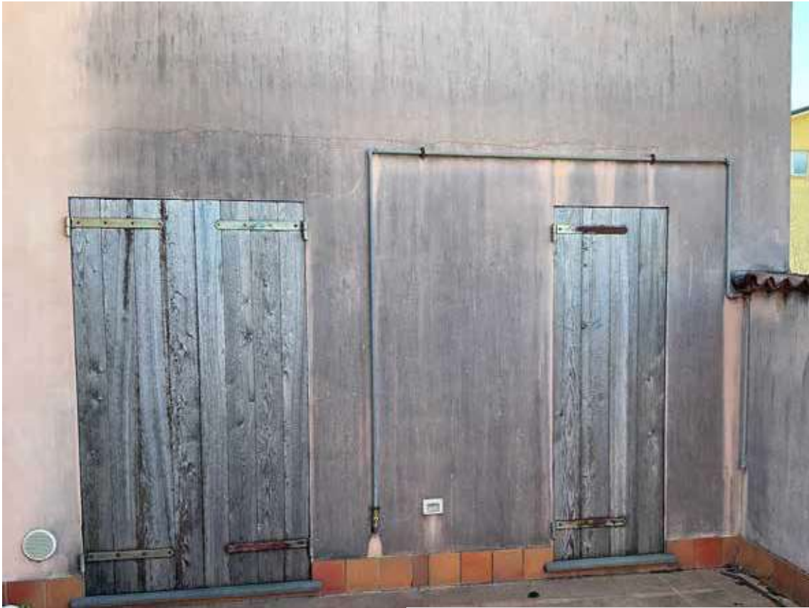
foto 41 - vista terrazzo LOTTO 2
