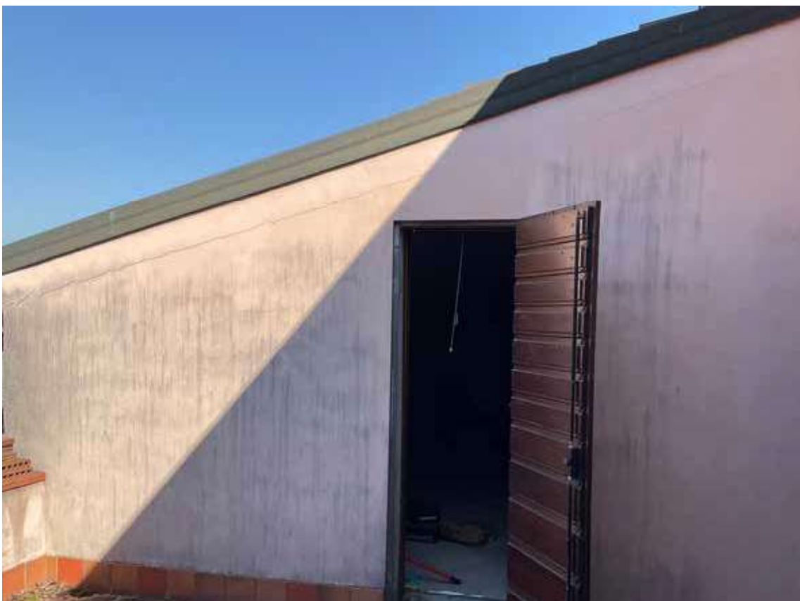
foto 40 - vista terrazzo LOTTO 2
