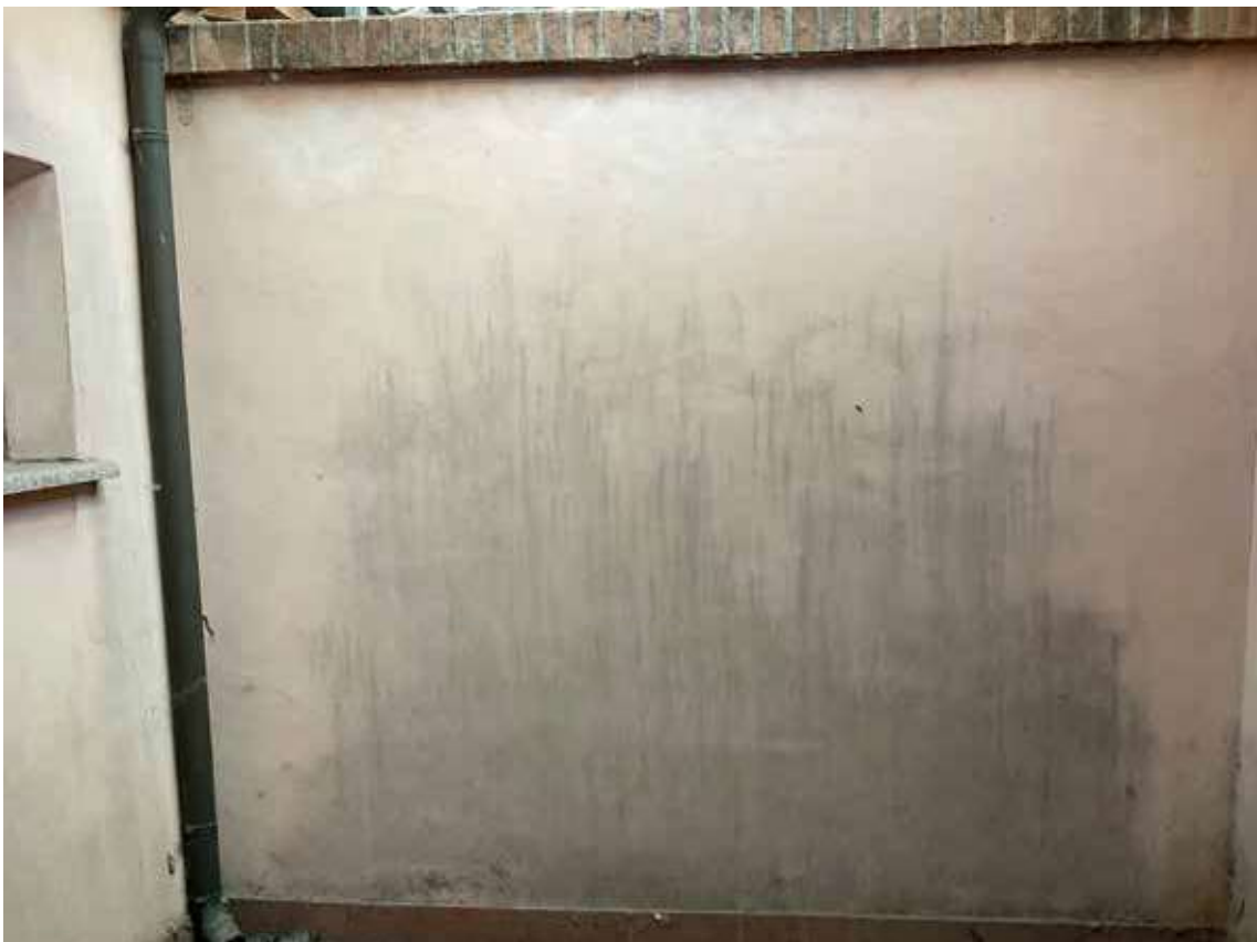
foto 42 - vista terrazzo LOTTO 2
