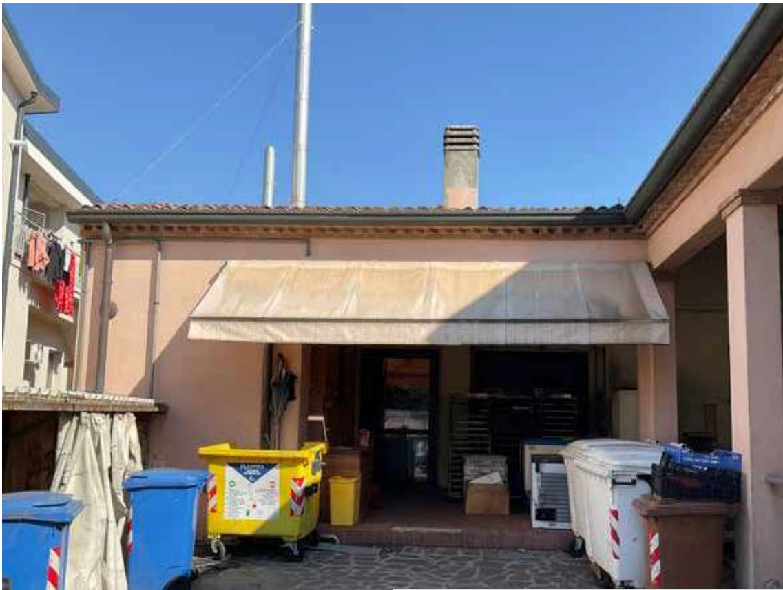
foto 17 - vista portico LOTTO 1
