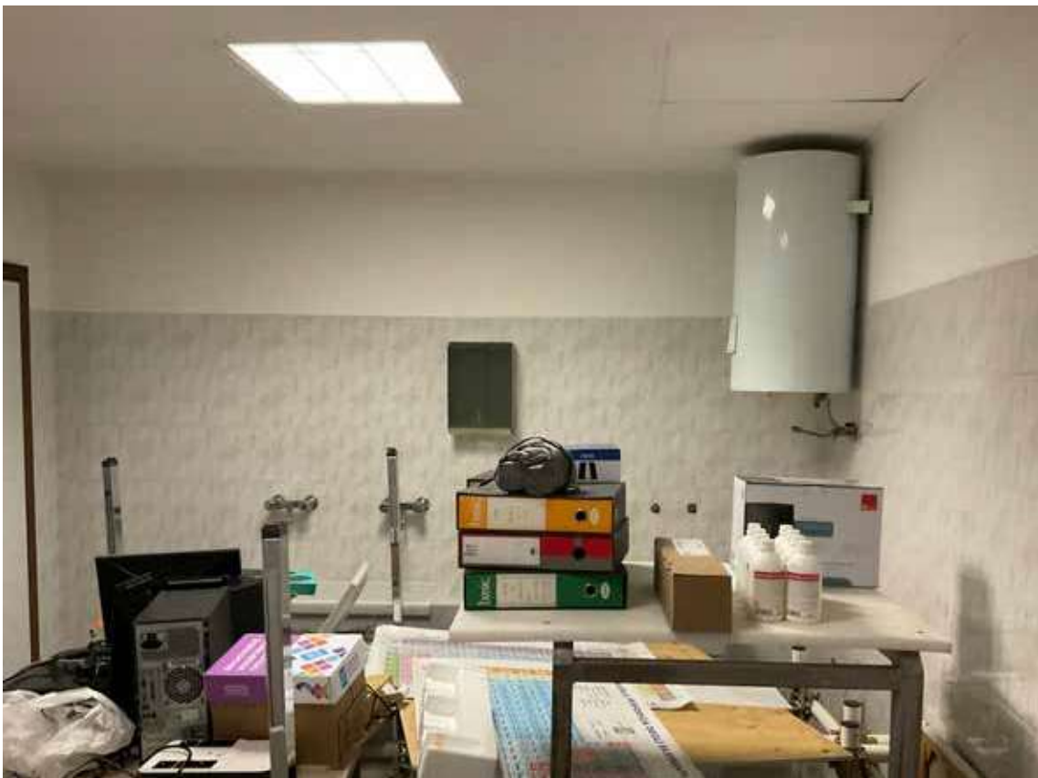
foto 66 - vista servizi zona magazzino LOTTO 3
