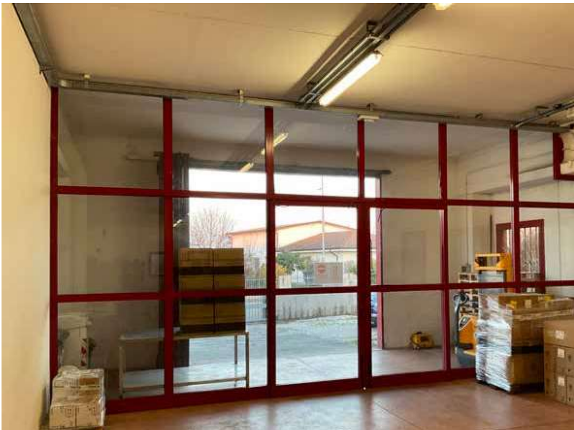
foto 60 - vista zona magazzino LOTTO 3
