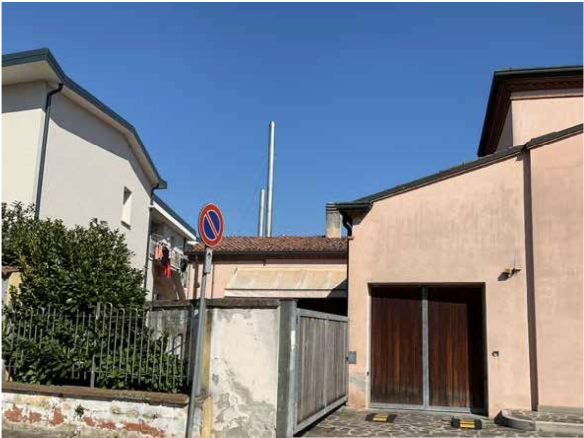
foto 03 - ingresso carraio LOTTO 1
