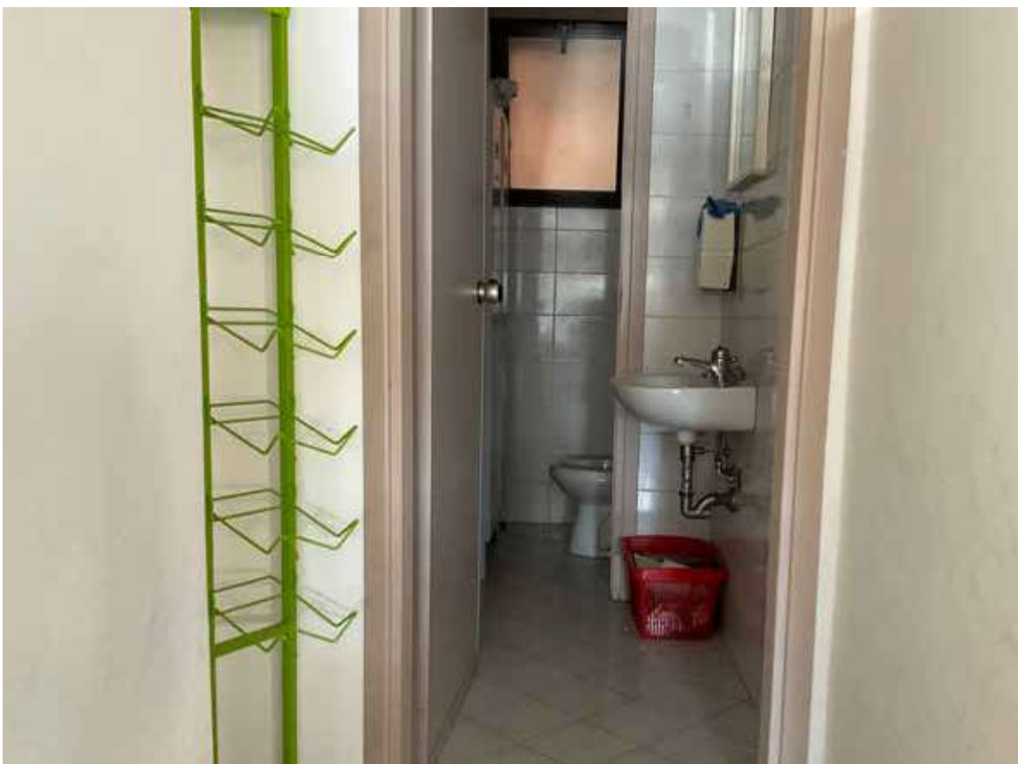
foto 12 - vista servizi LOTTO 1
