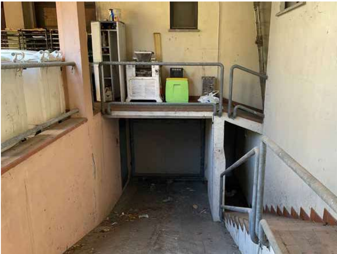
foto 21 - vista interrato LOTTO 1
