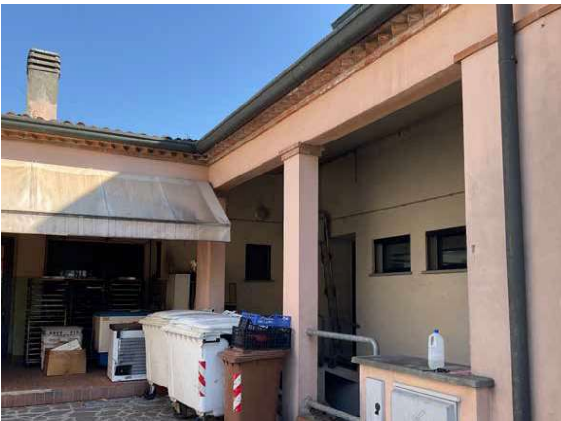
foto 18 - vista portico LOTTO 1
