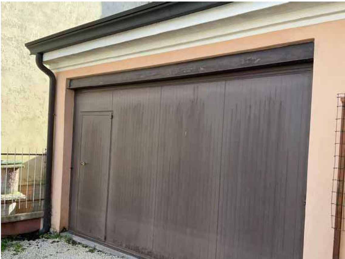
foto 95 - vista autorimessa LOTTO 5
