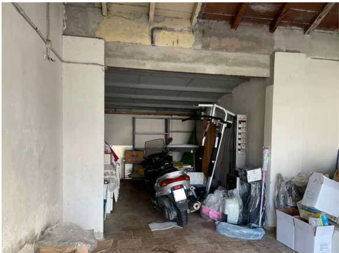
foto 96 - vista autorimessa LOTTO 5
