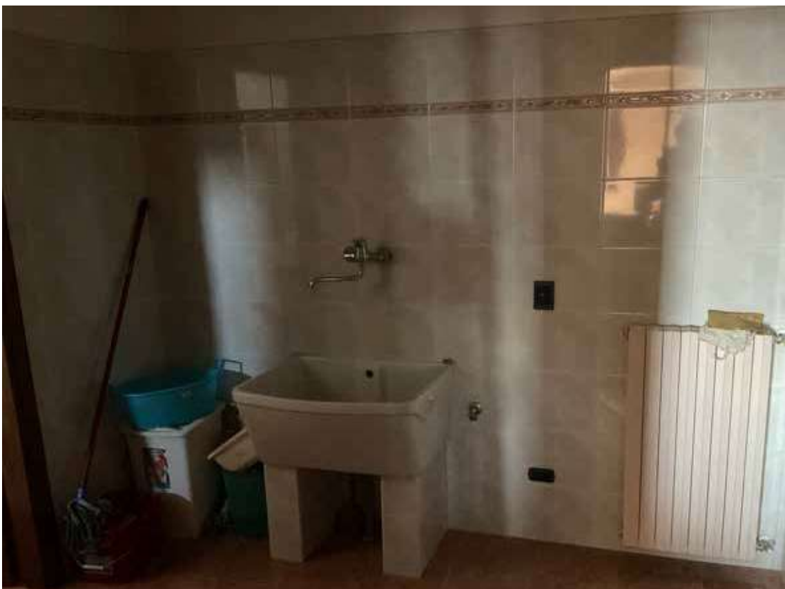
foto 30 - vista lavanderia LOTTO 2
