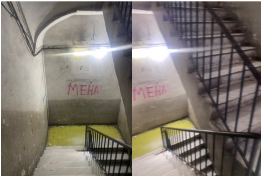
FOTO INTERNE AL VANO SCALA
