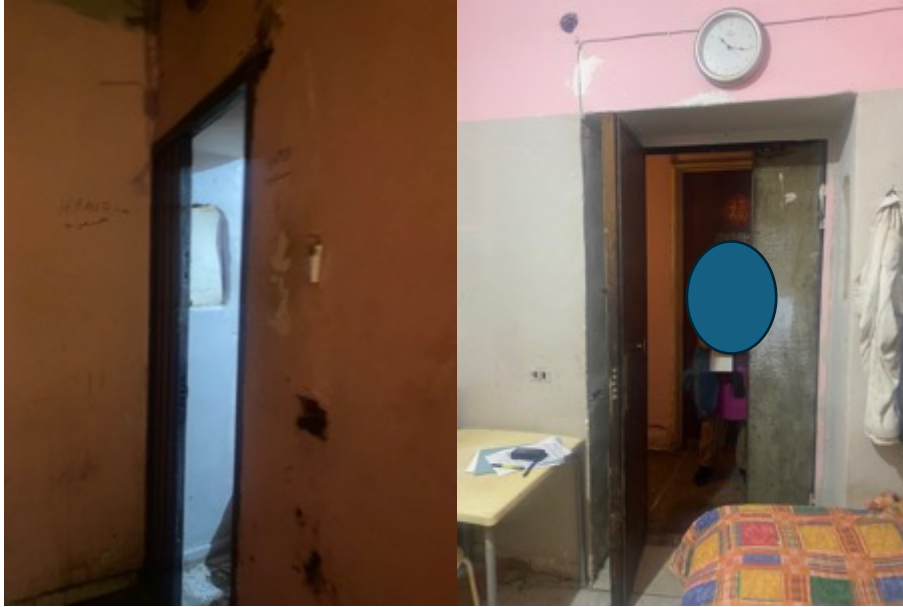
Foto da 1 a 2: Vista Ingresso alloggio
