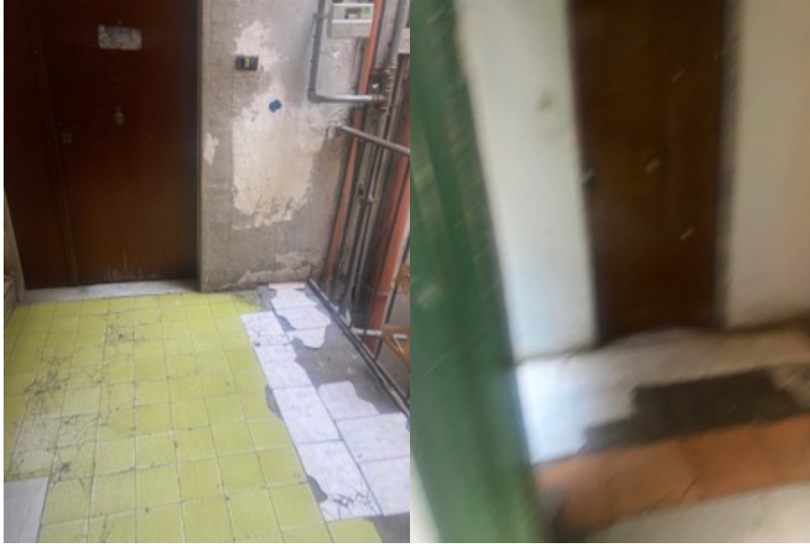
FOTO INTERNE AL VANO SCALA
