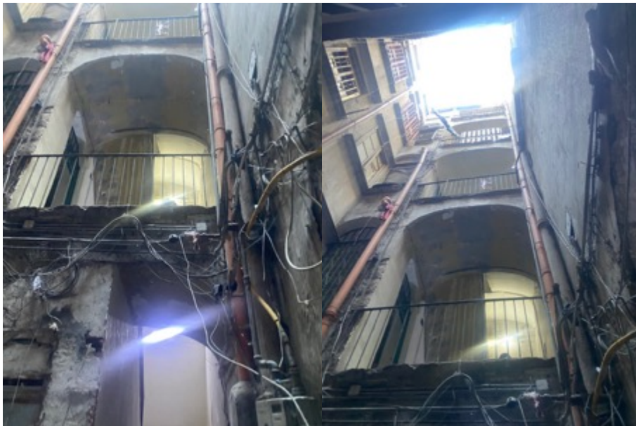
Vista vano scala
