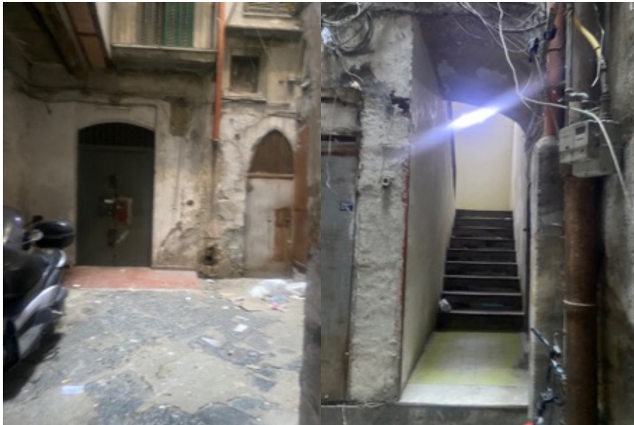
Vista vanella e vano scala
