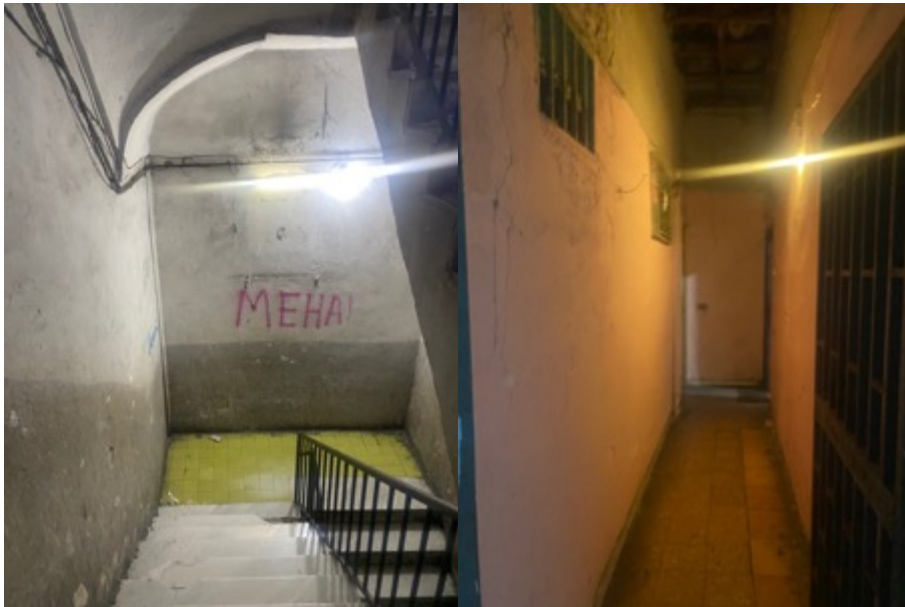
Vista vano scala e corridoio comune d'accesso all'alloggio pignorato
