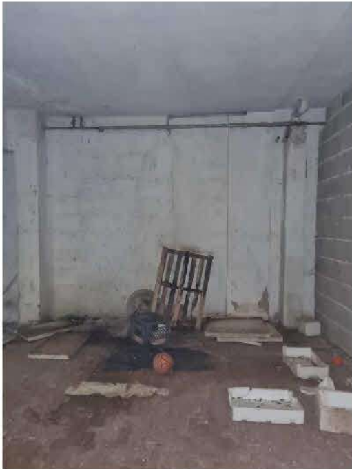
Area di manovra
