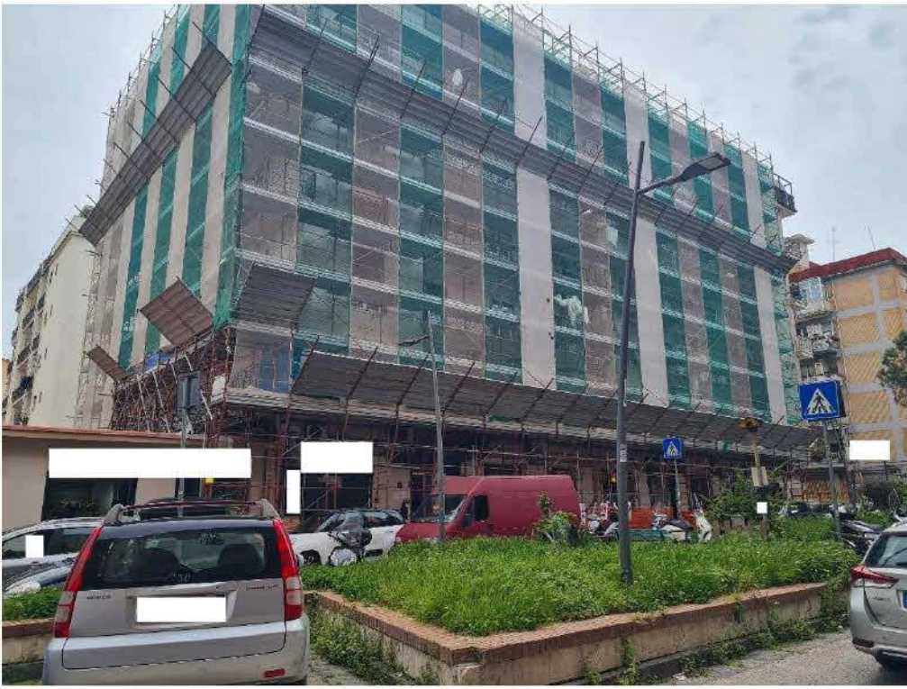
Prospetto principale del fabbricato su via Nicolardi
