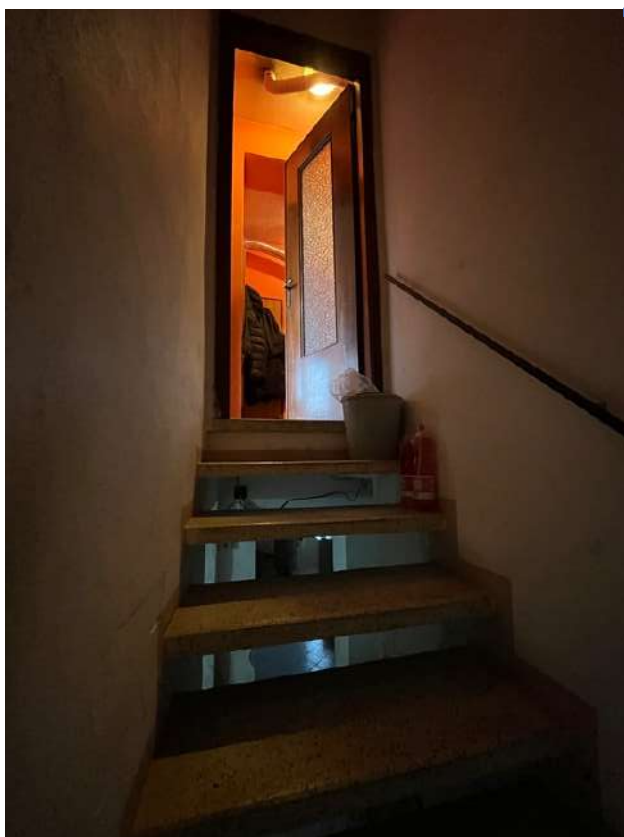
Foto 21 : La scala che conduce al piano terra
