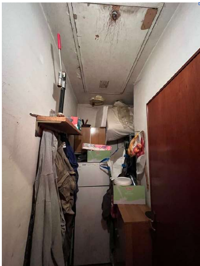
Foto 15 : Ripostiglio piano primo con botola di ispezione sottotetto
