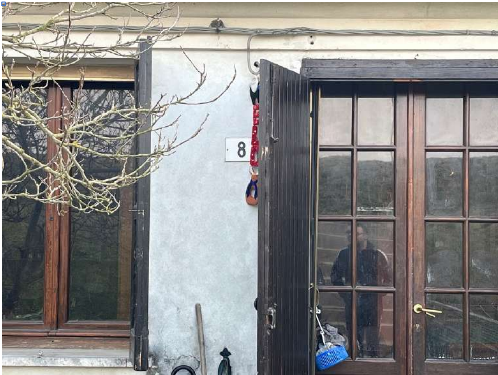
Numero civico dell'edificio residenziale oggetto di pignoramento
