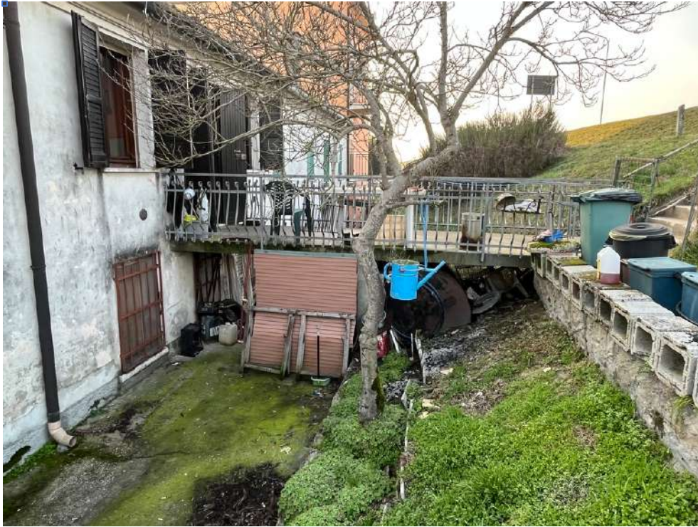
Foto 2 : Ponticello di accesso al piano primo dell'unità residenziale
