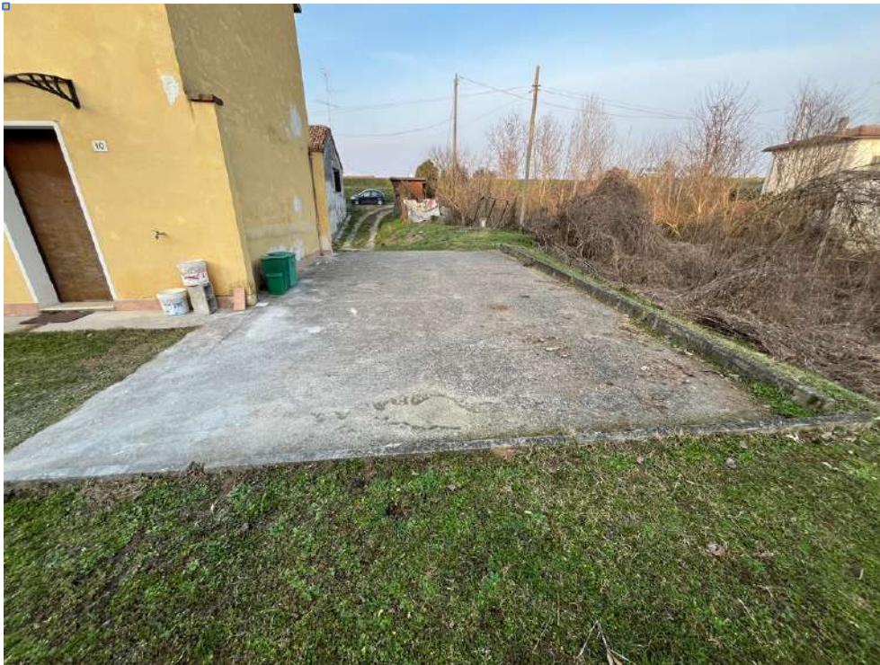
Foto 8 : Sedime su cui era edificato un rustico e il box auto – ora demoliti – altra vista
