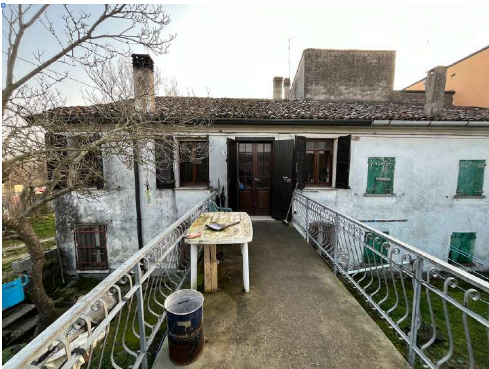
Foto 1 : Prospetto principale verso Via Molinara
