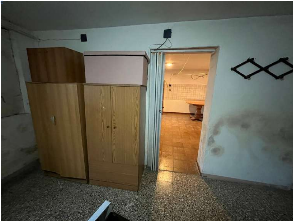
Foto 24 : La porta di collegamento ad altra stanza ripostiglio
