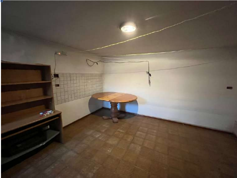
Foto 26 : La seconda stanza ripostiglio – verso l’argine maestro – altra vista
