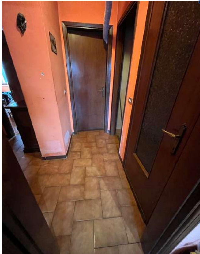
Foto 14 : Il disimpegno del piano primo
