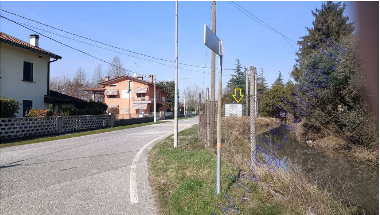
Corpo H CABINA ELETTRICA
