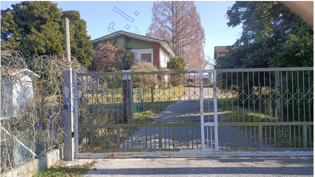
Corpo G FABBRICATO DI ABITAZIONE
