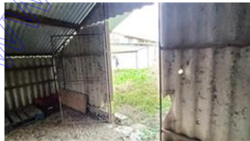
Veduta interna Corpo E
