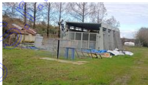
Resti dell'impianto Biogas posizionato sul sedime del Corpo E3 e E4
