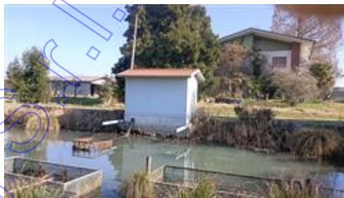
Parte iniziale del mappale 89: dettaglio argine
