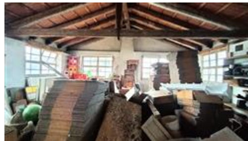
Piano primo (deposito)
