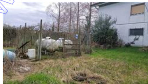
Veduta esterno (serbatoi gas)
