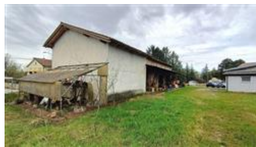
Pensilina e tettoia aggiunte non autorizzate
