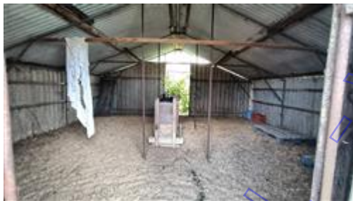
Veduta interna Corpo E
