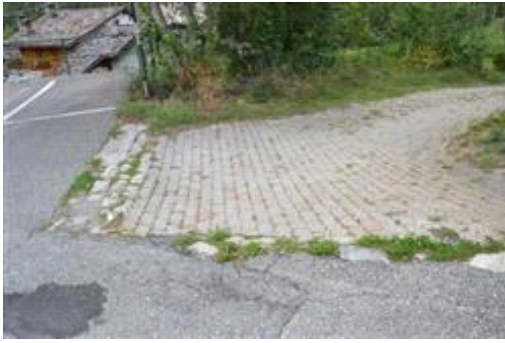
Ingresso rampa di accesso alle autorimesse
