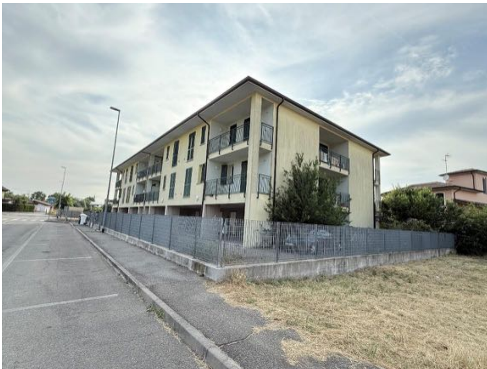
Fabbricato - Vista da via A. De Gasperi (foto 1)
