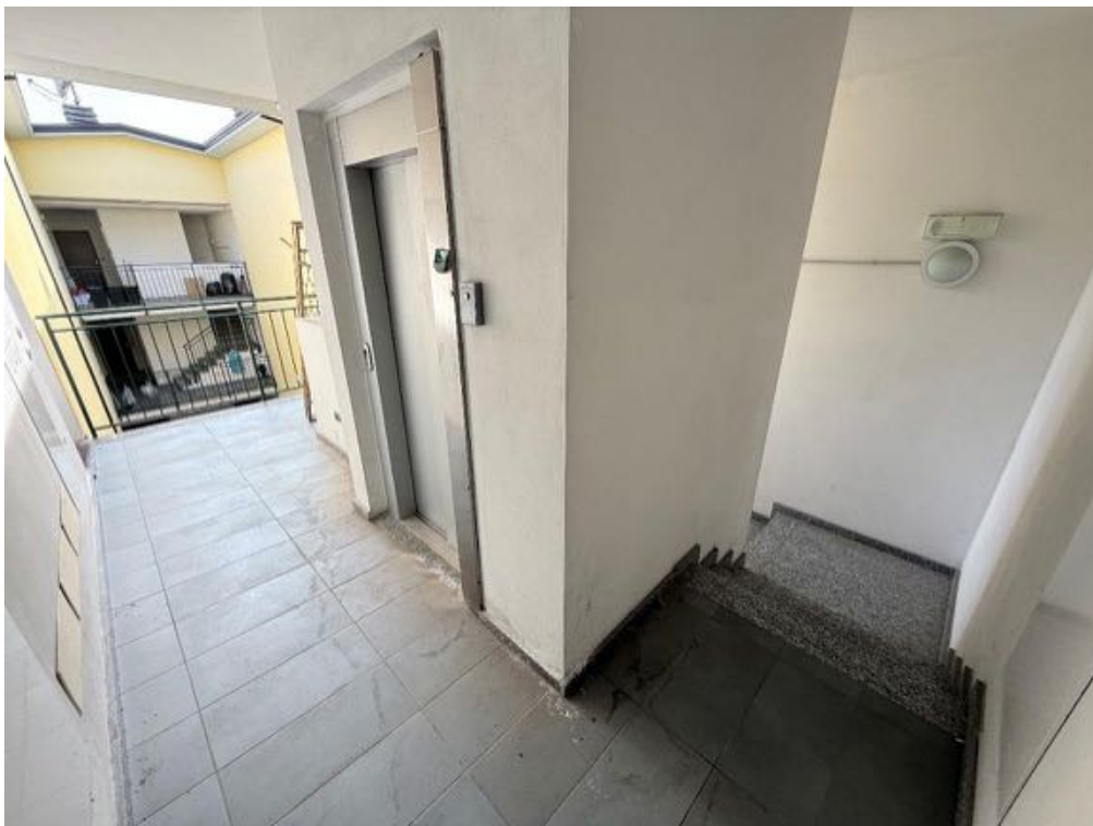
Fabbricato - Scala B - Vano scala - Da Piano Primo a Piano Secondo (foto 4)
