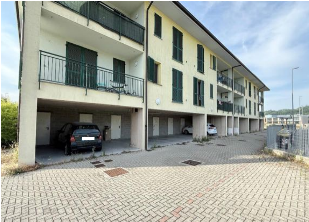
Fabbricato - Area cortilizia/Corsello anteriore (foto 4)
