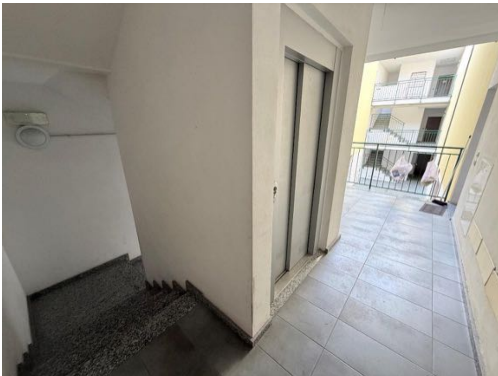
Fabbricato - Scala A - Vano scala - Da Piano Terra a Piano Primo (foto 4)
