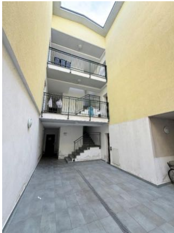
Fabbricato - Androne d'ingresso - Vista verso Scala A
