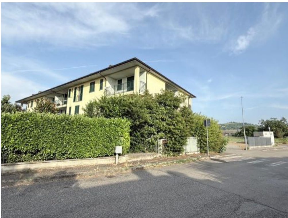
Fabbricato - Vista da via Padania (foto 5)
