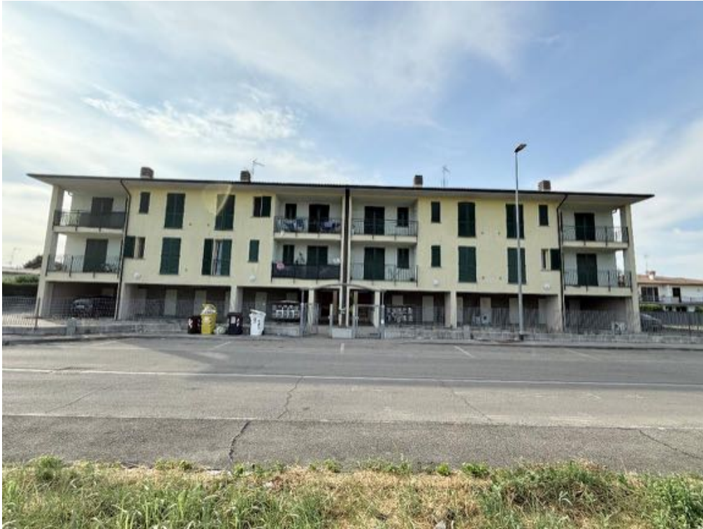
Fabbricato - Vista da via A. De Gasperi (foto 4)
