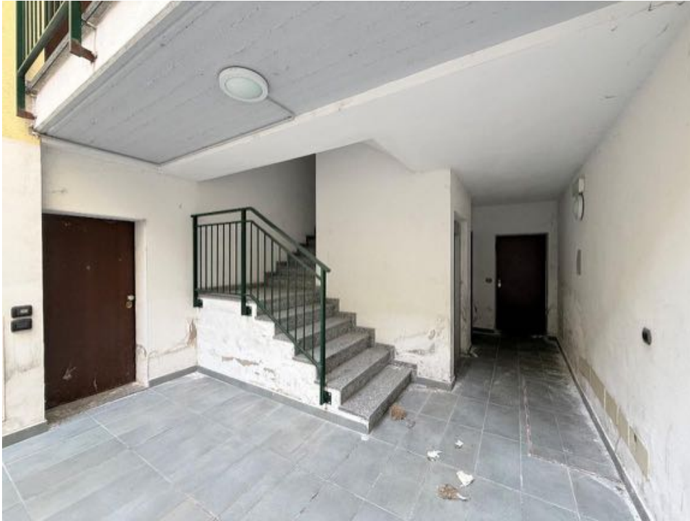
Fabbricato - Scala B - Vano scala - Da Piano Terra a Piano Primo (foto 1)
