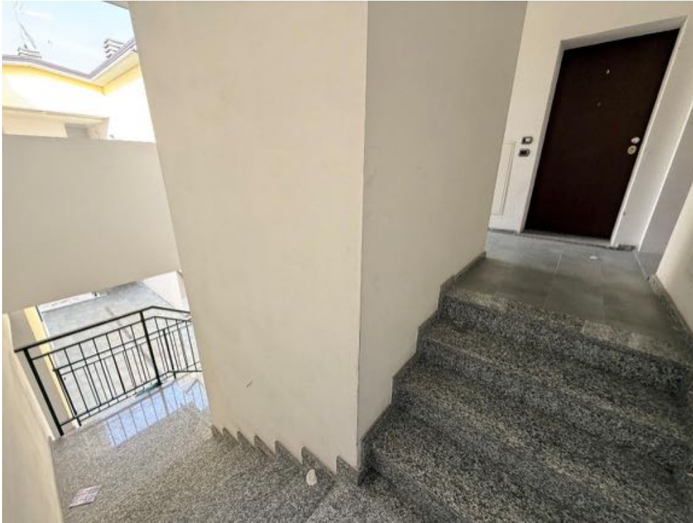
Fabbricato - Scala A - Vano scala - Da Piano Primo a Piano Secondo (foto 3)
