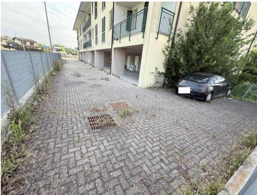
Fabbricato - Area cortilizia/Corsello anteriore (foto 6)
