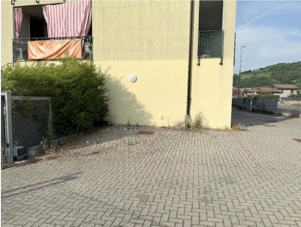
Fabbricato - Area cortilizia/Corsello anteriore (foto 1)
