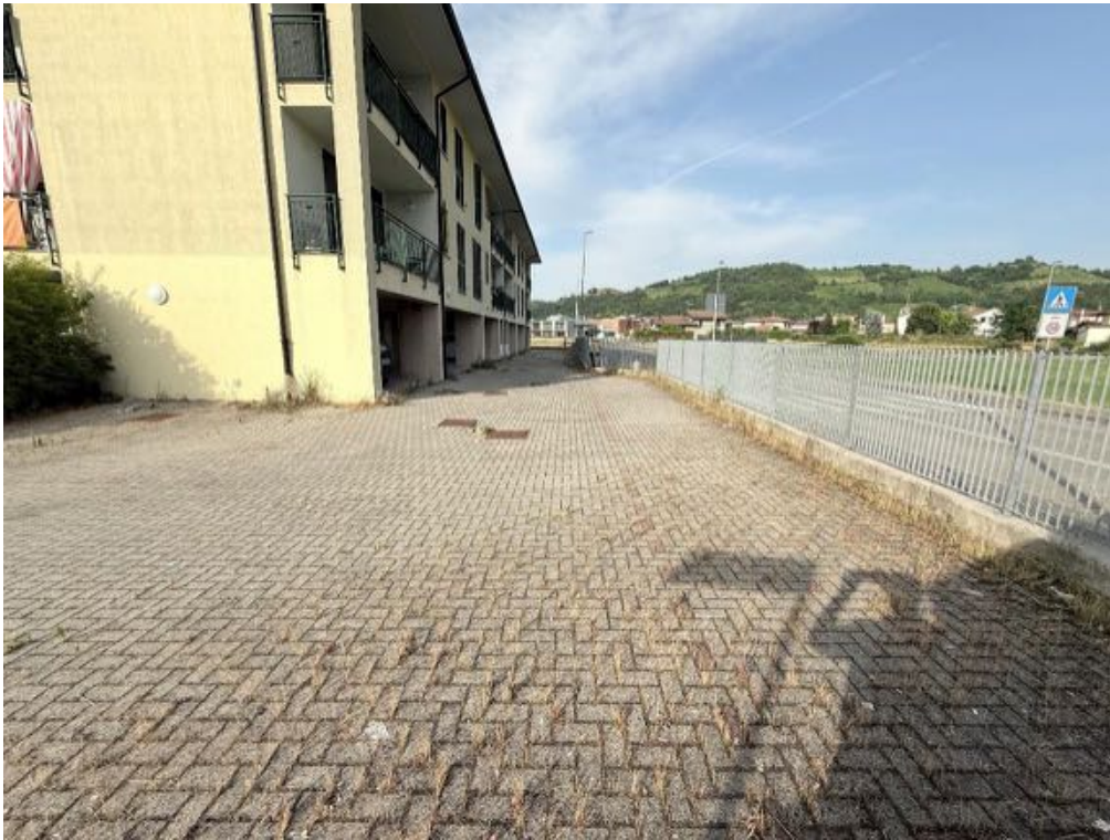
Fabbricato - Area cortilizia/Corsello anteriore (foto 3)
