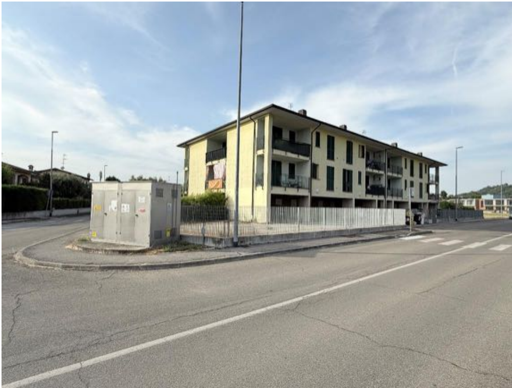
Fabbricato - Vista da via A. De Gasperi (foto 7)
