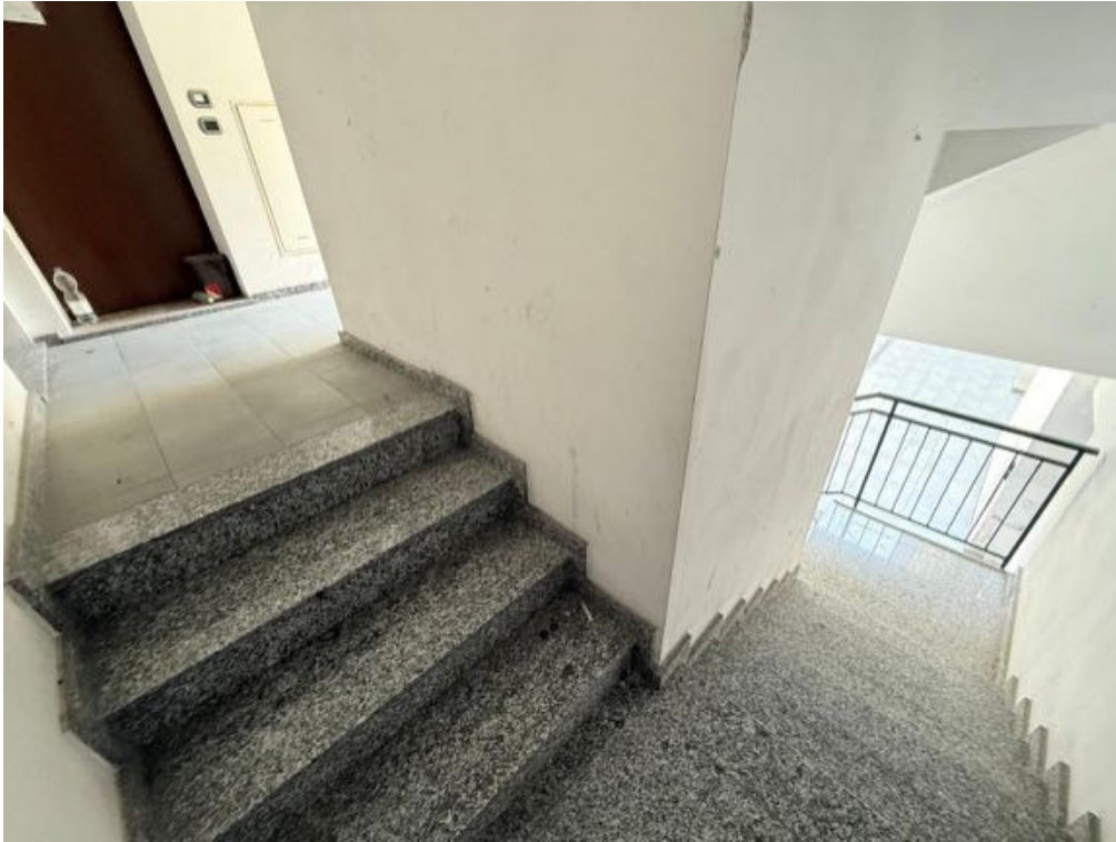
Fabbricato - Scala B - Vano scala - Da Piano Terra a Piano Primo (foto 3)
