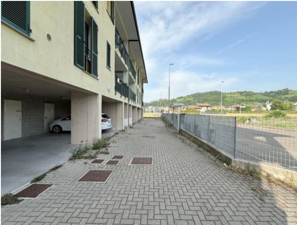
Fabbricato - Area cortilizia/Corsello anteriore (foto 5)
