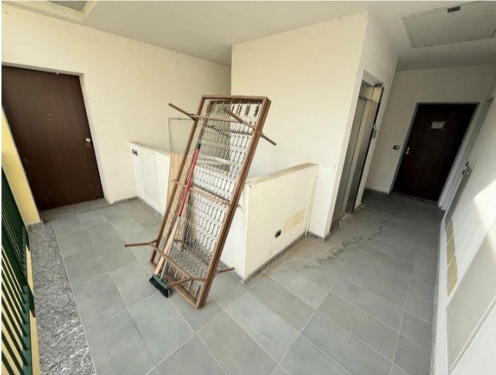
Fabbricato - Scala B - Vano scala - Da Piano Primo a Piano Secondo (foto 5)
