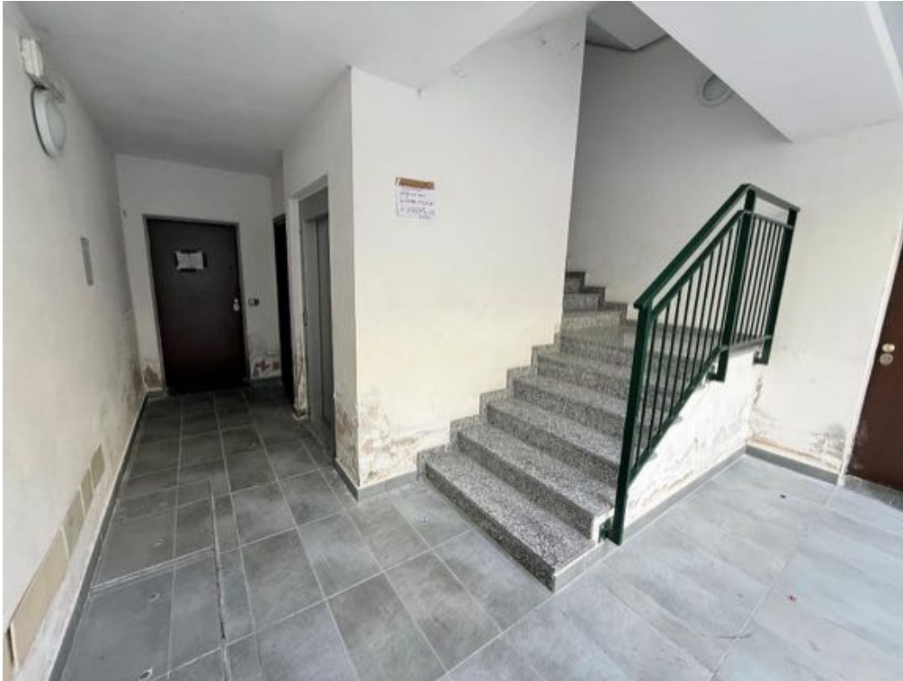
Fabbricato - Scala A - Vano scala - Da Piano Terra a Piano Primo (foto 1)
