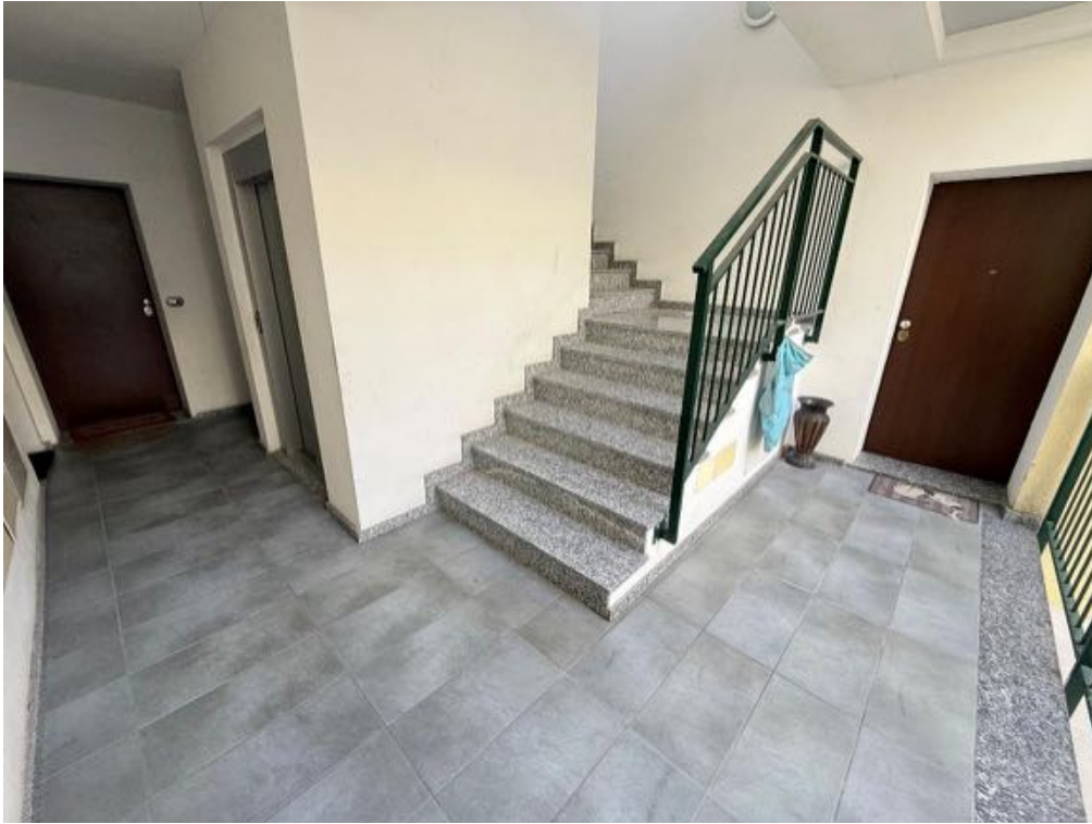
Fabbricato - Scala A - Vano scala - Da Piano Primo a Piano Secondo (foto 1)
