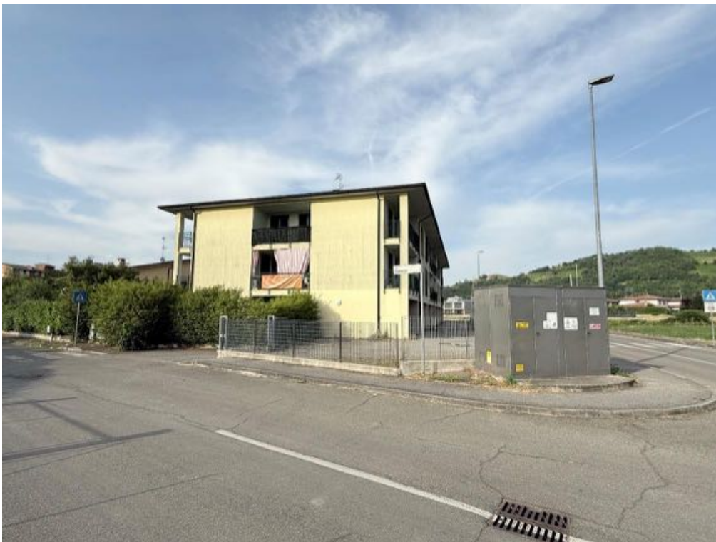
Fabbricato - Vista da via Padania (foto 1)
