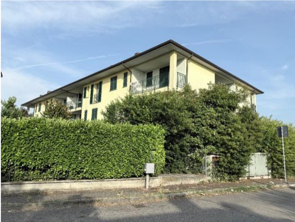
Fabbricato - Vista da via Padania (foto 6)
