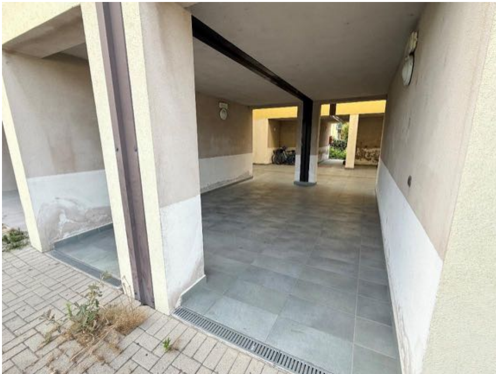
Fabbricato - Androne d'ingresso (foto 1)
