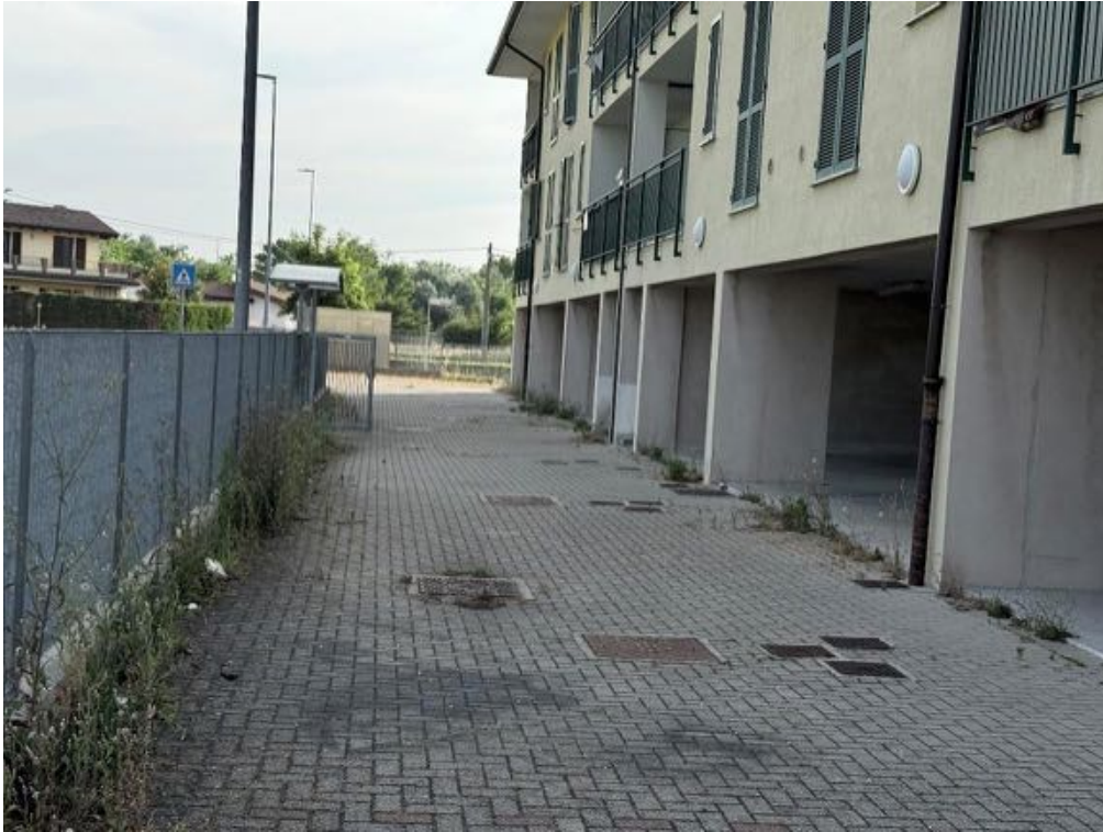
Fabbricato - Area cortilizia/Corsello anteriore (foto 9)
