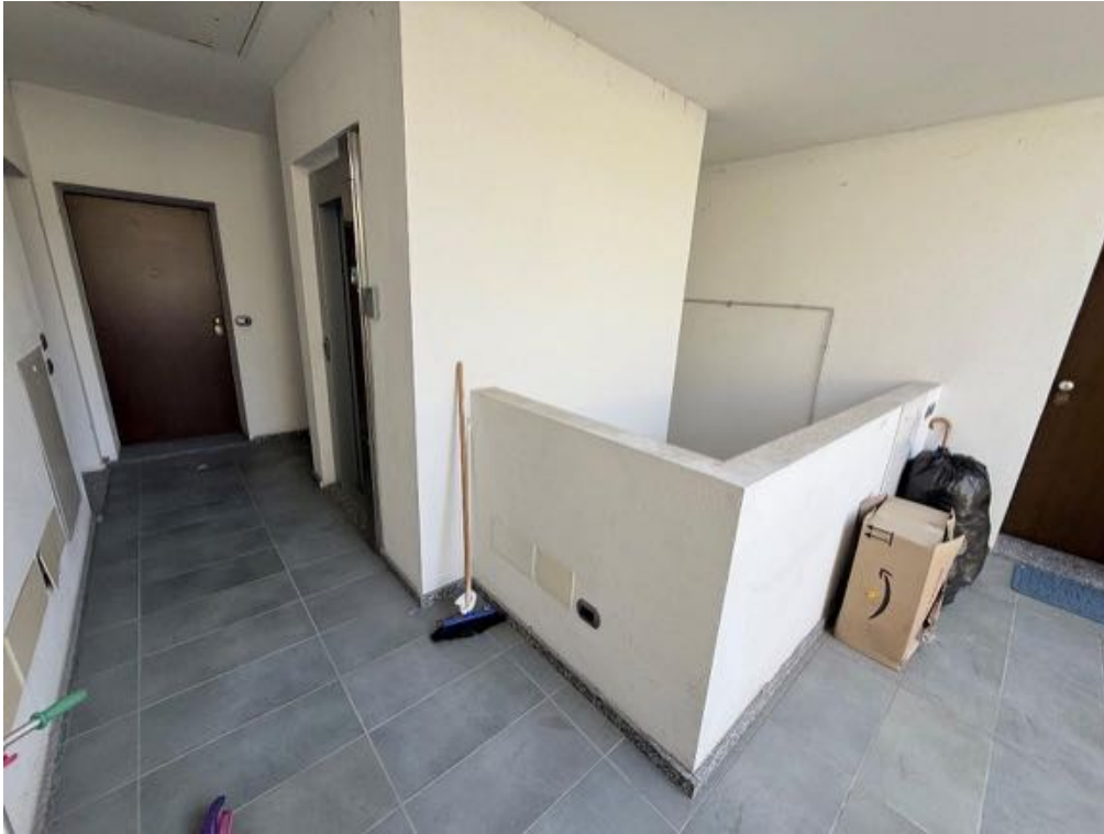
Fabbricato - Scala A - Vano scala - Da Piano Primo a Piano Secondo (foto 5)
