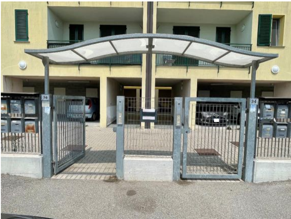
Fabbricato - Accesso pedonale da via A. De Gasperi
