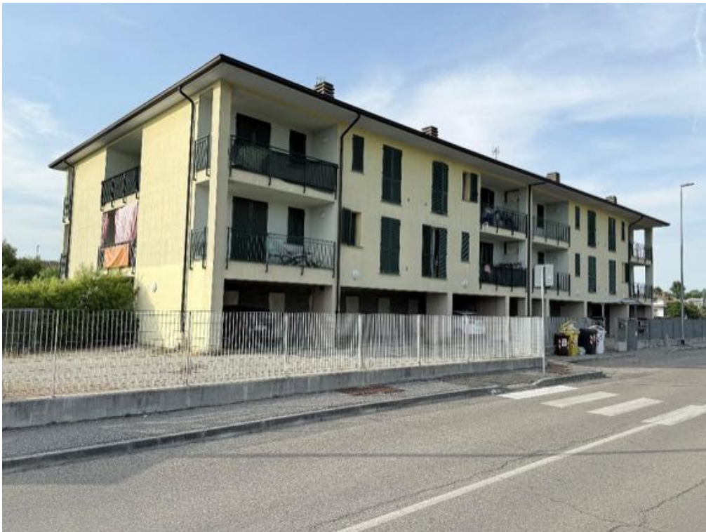
Fabbricato - Vista da via A. De Gasperi (foto 6)
