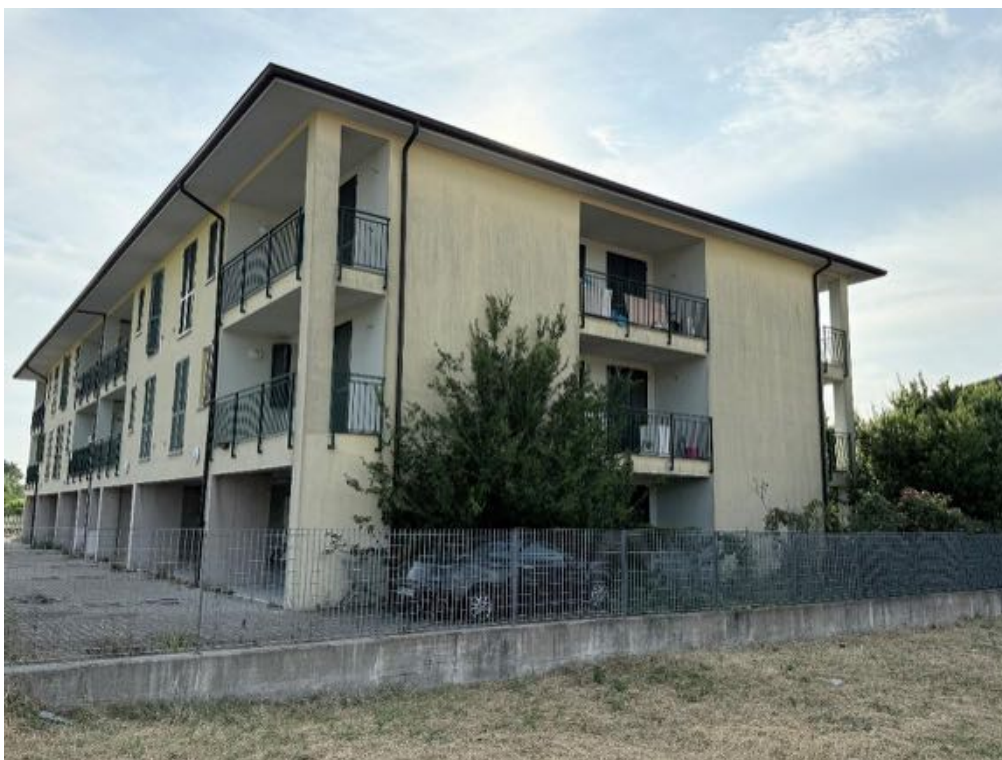
Fabbricato - Vista da via A. De Gasperi (foto 2)
