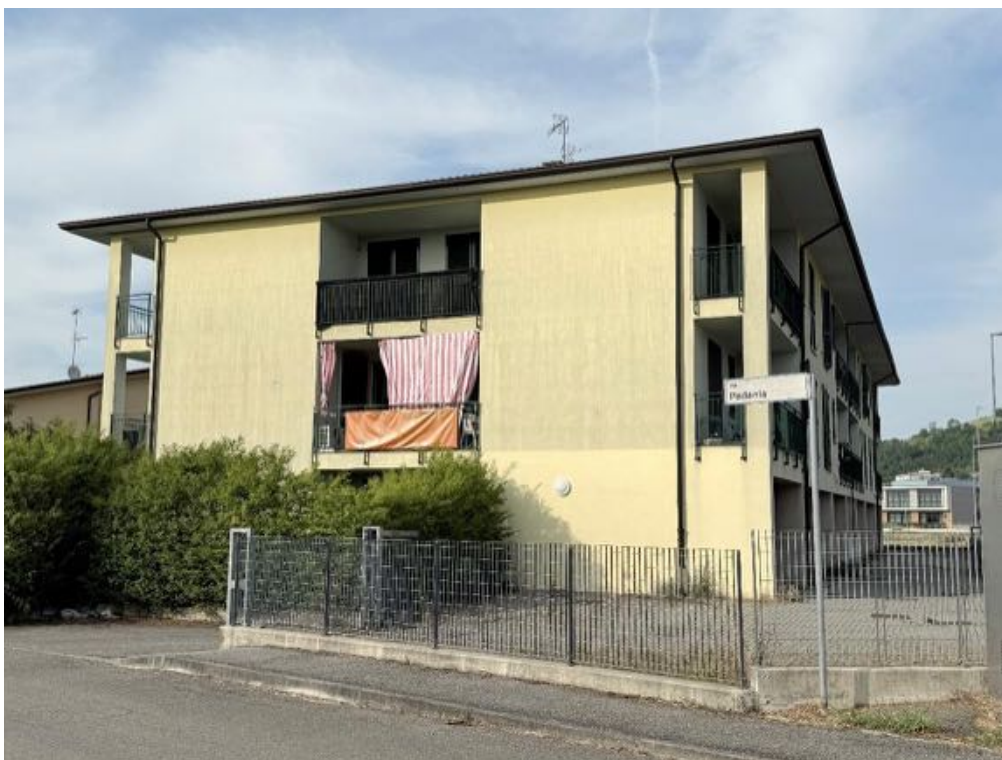
Fabbricato - Vista da via Padania (foto 2)
