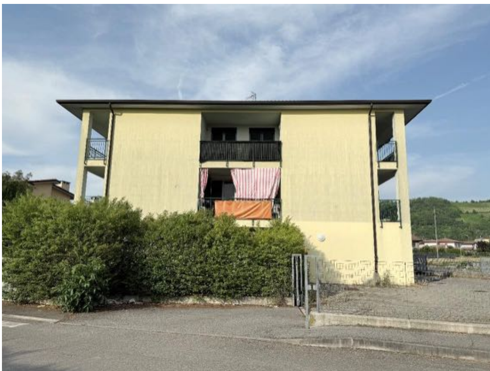
Fabbricato - Vista da via Padania (foto 3)
