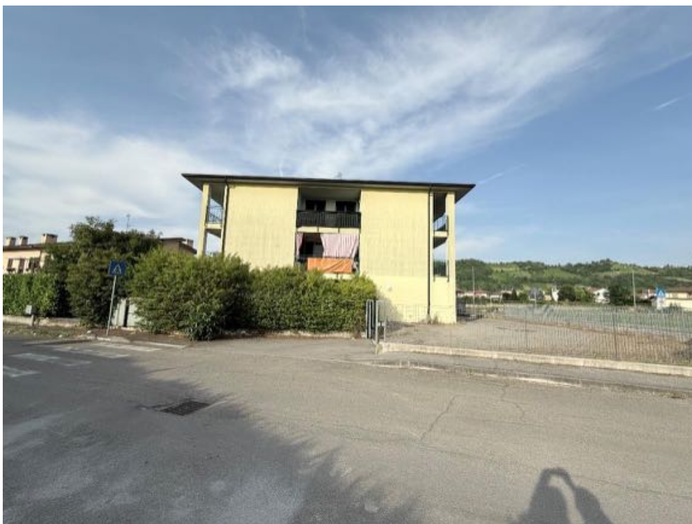
Fabbricato - Vista da via Padania (foto 4)
