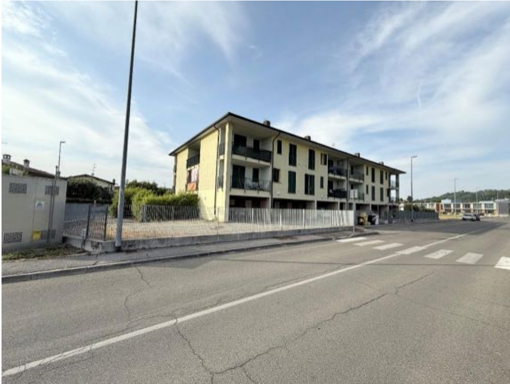
Fabbricato - Vista da via A. De Gasperi (foto 5)
