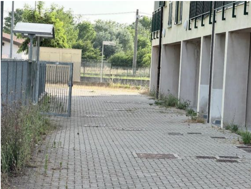
Fabbricato - Area cortilizia/Corsello anteriore (foto 10)
