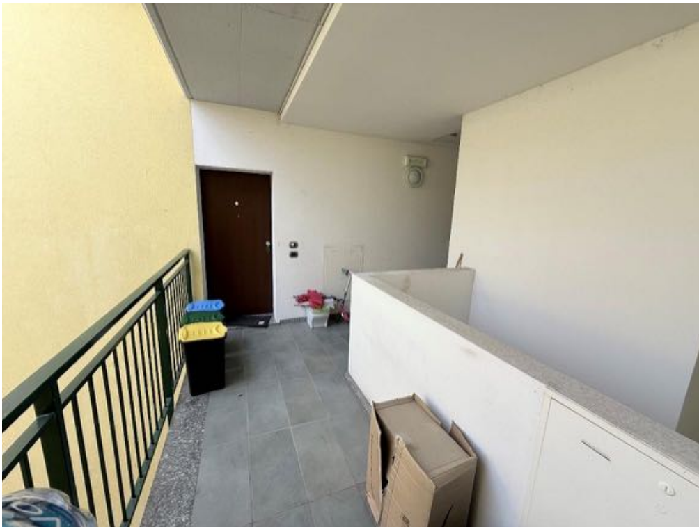
Fabbricato - Scala A - Vano scala - Da Piano Primo a Piano Secondo (foto 6)
