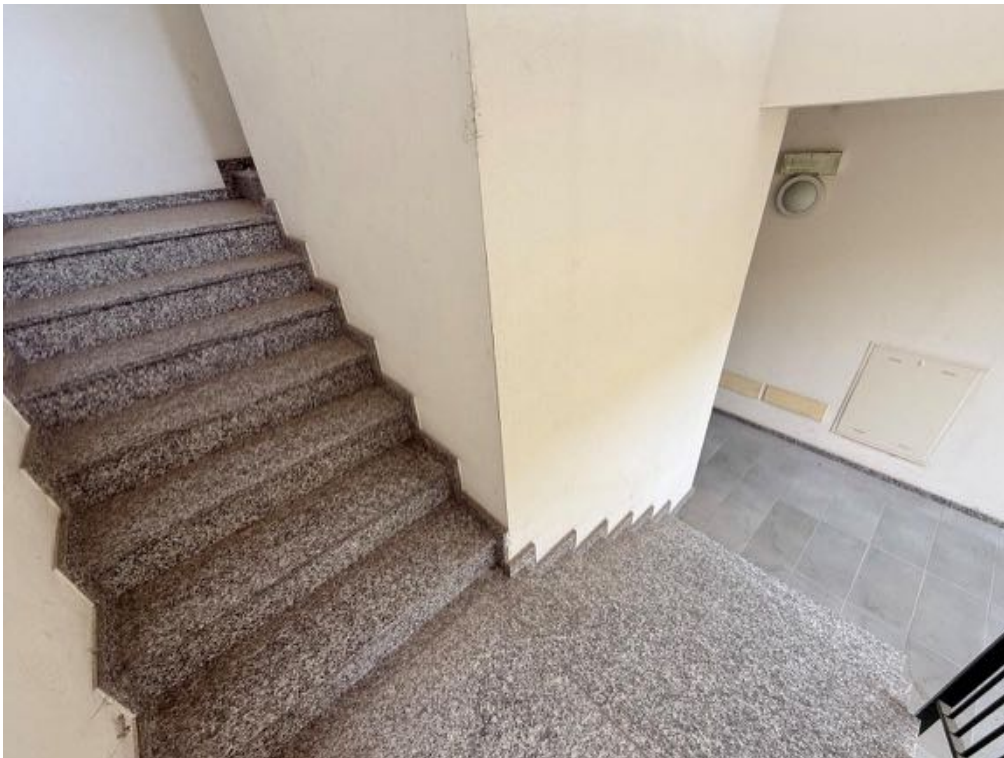
Fabbricato - Scala B - Vano scala - Da Piano Primo a Piano Secondo (foto 2)
