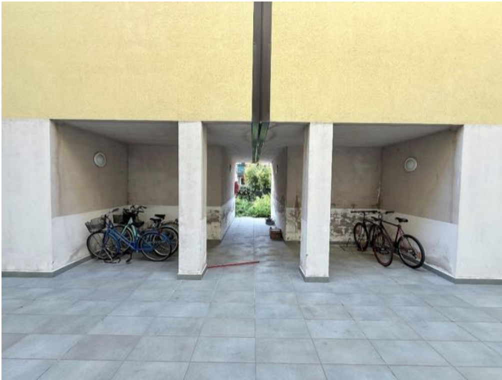
Fabbricato - Androne d'ingresso (foto 2)
