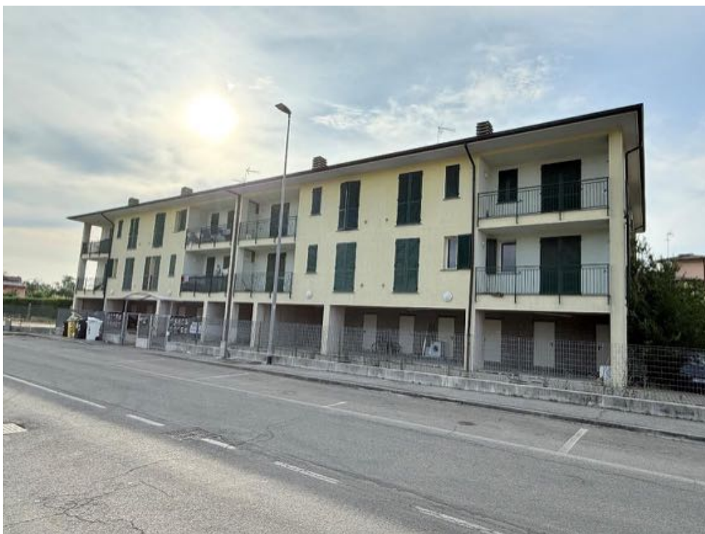
Fabbricato - Vista da via A. De Gasperi (foto 3)
