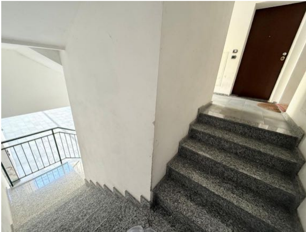
Fabbricato - Scala A - Vano scala - Da Piano Terra a Piano Primo (foto 3)
